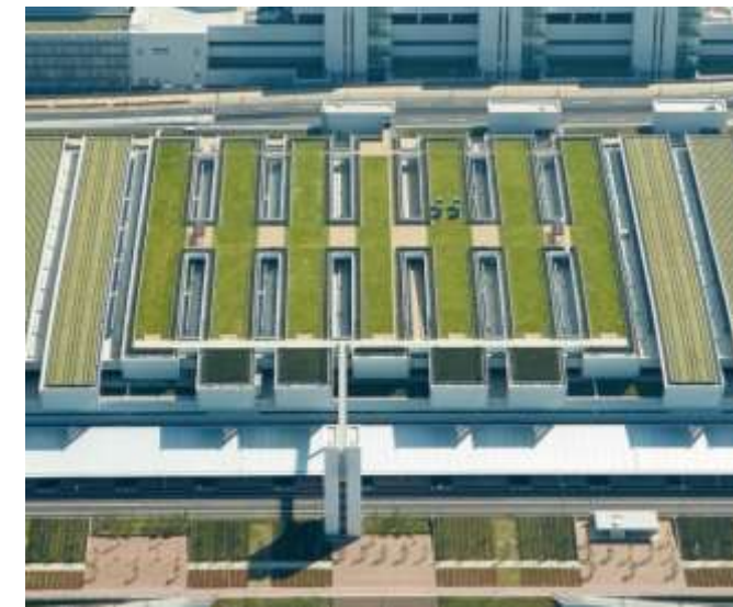
6街区 屋上緑化広場
