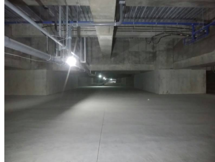
(床面コンクリートの打設)
