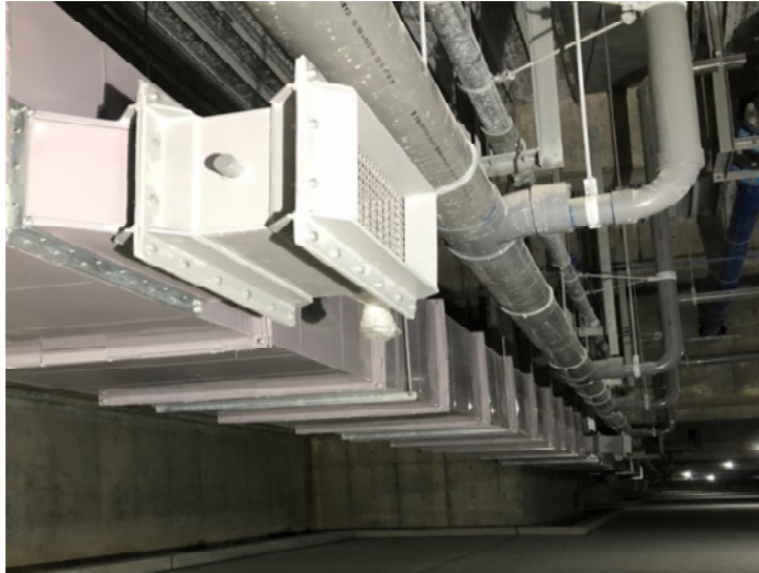
(換気設備の設置)
