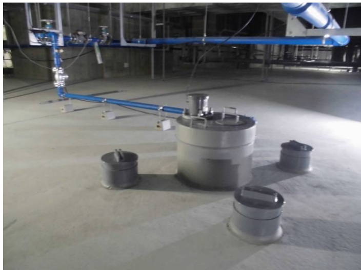
(地下ピット内の揚水ポンプの設置等)
