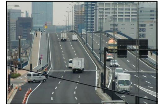
環状第2号線暫定迂回道路
