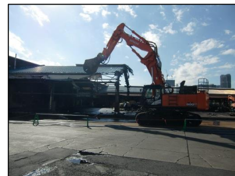
解体工事状況(第4工区) (平成30年11月20日)
