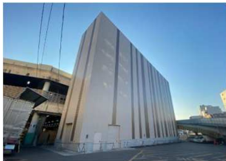
<自動立体冷蔵倉庫> (発注者：市場業者)
