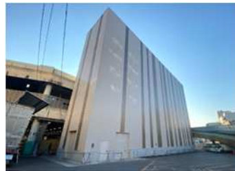
< 淀橋市場 自動立体冷蔵倉庫 >
