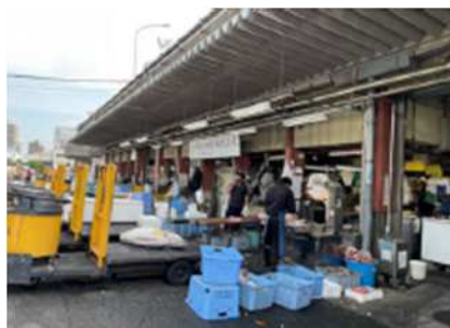
【衛生対策工事】（足立市場）
