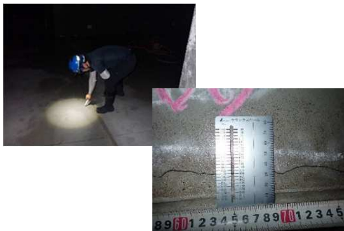
<令和7年度点検の様子>
