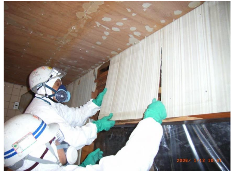
成型板の取り外し (手ばらし)
