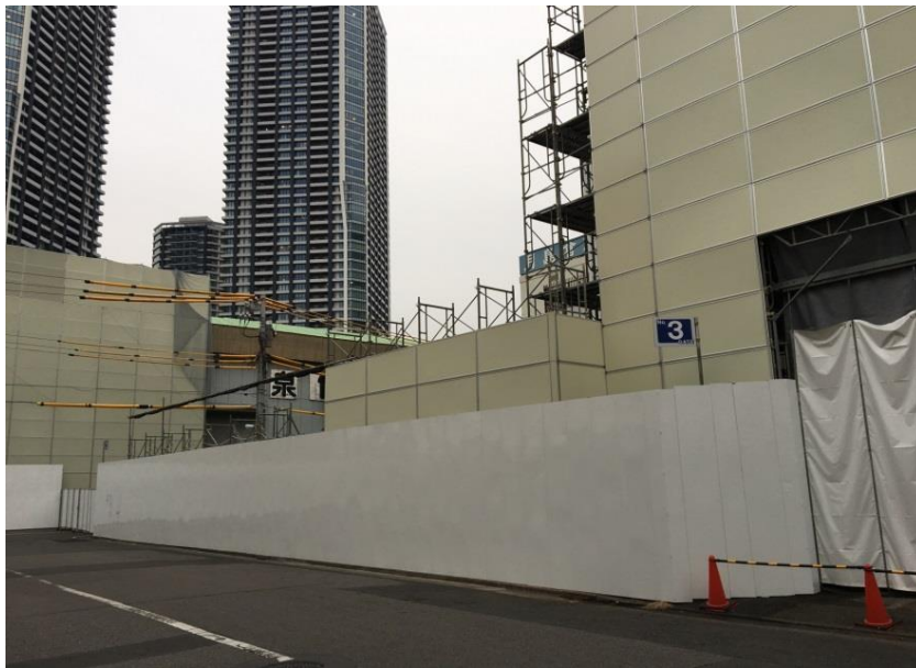
①仮囲い ②建物の囲い
