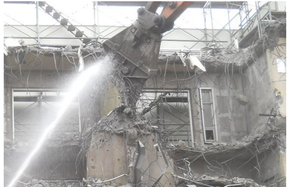
④躯体の解体
