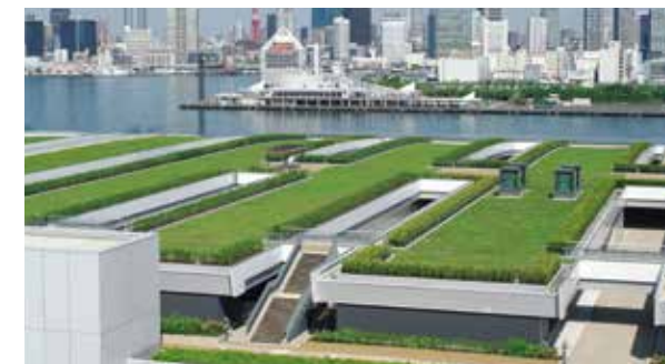
屋上緑化広場
