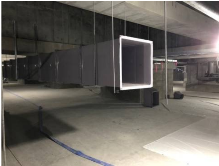
(換気工事の実施状況)
