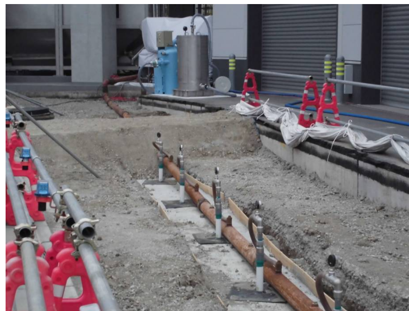
(真空ポンプによる揚水の実施状況)
