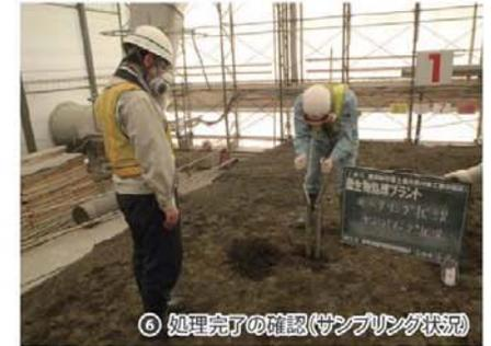
6 処理完了の確認(サンプリング状況)
