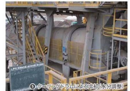
⑤ クーリングドラムによる冷却(水分調整)
