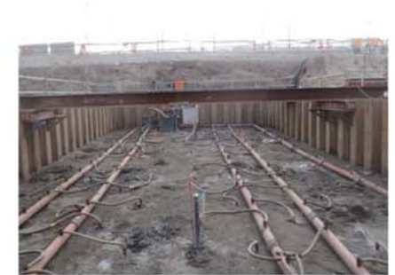
ウェルポイント設置状況
