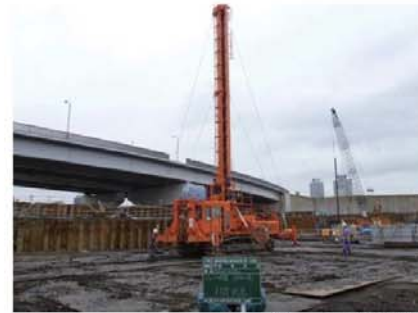
ドレーン材打設状況
