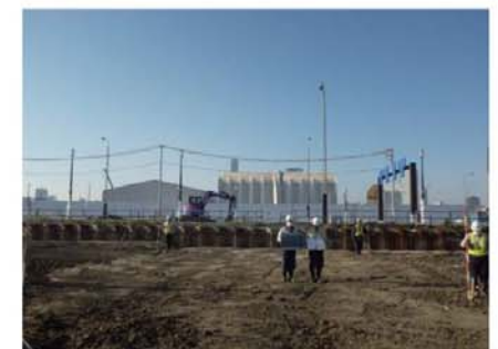
地下水対策完了確認
