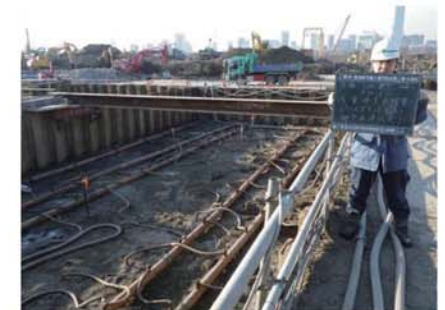
地下水対策完了確認
