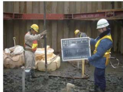
ウェルポイント設置状況
