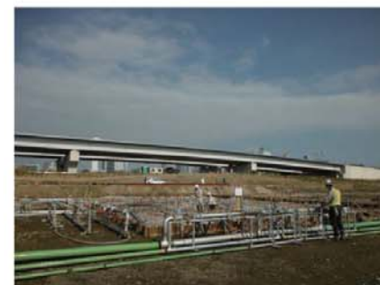
注水バイオスパーキング運転状況
