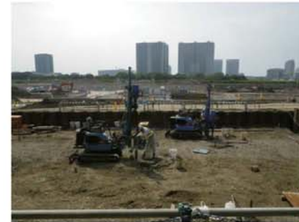
スパーキング井戸設置状況
