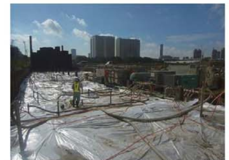
注水バイオスパーキング運転状況
