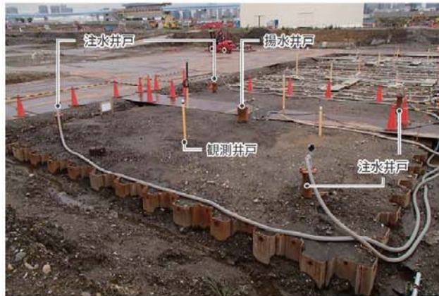
ディープウェル工法運転状況
