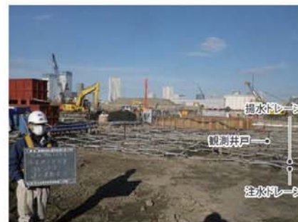
真空ドレーン運転状況
