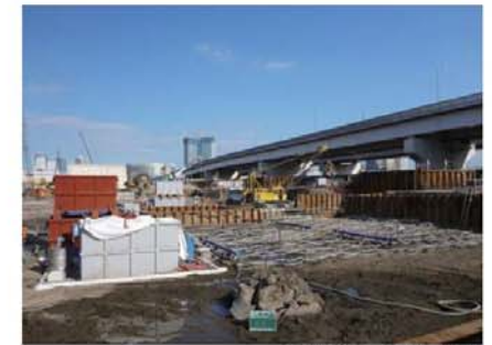
真空ドレーン設置状況
