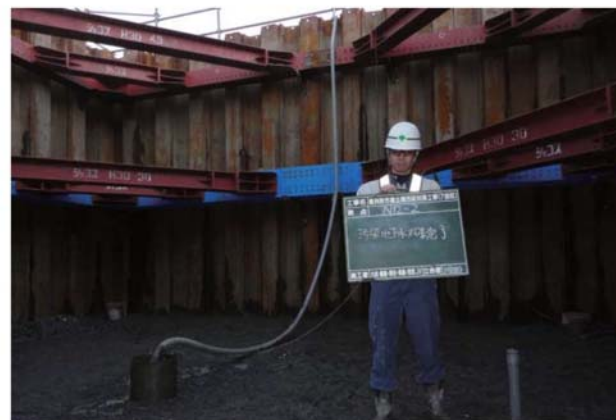
地下水対策完了確認
