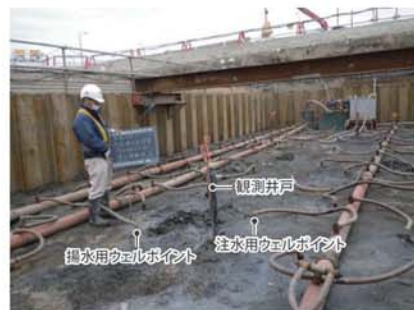
ウェルポイント運転状況
