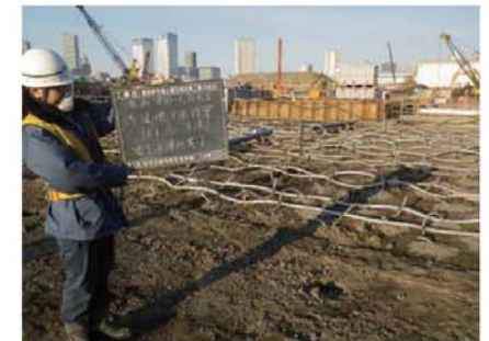
地下水対策完了確認
