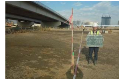
盛土完了(全景)
