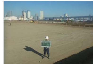
盛土完了(全景)
