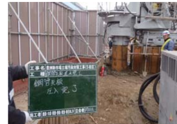
鋼管矢板打設状況(圧入工法)(5 街区)
