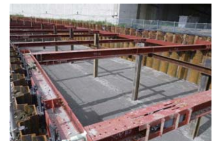
碎石層設置完了
