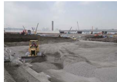
碎石敷き均し状況
