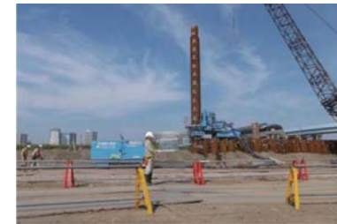
鋼管矢板打設状況(圧入工法)(6 街区)
