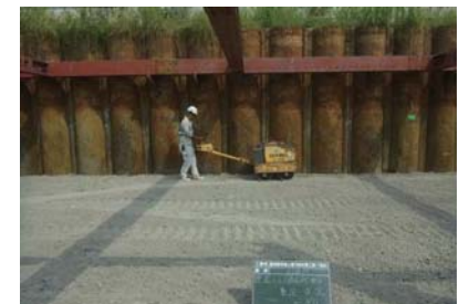
碎石転圧状況
