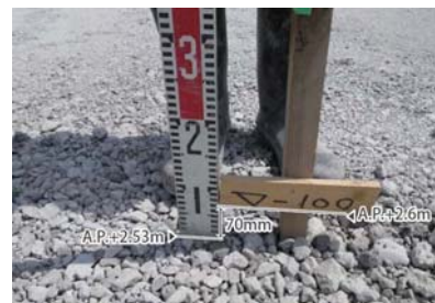
碎石層の高さ確認(拡大)
