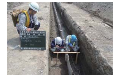
三層構造遮水壁設置完了
