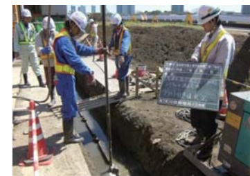
継手部充填材注入
