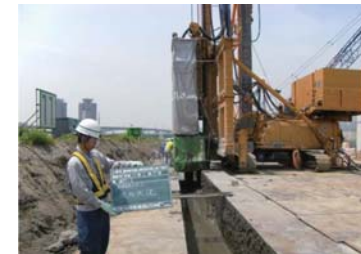
ソイルセメント壁造成状況(7 街区)
