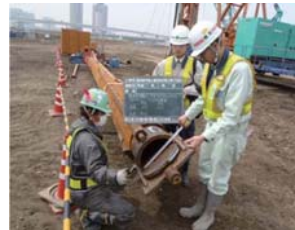
施工機械の確認
