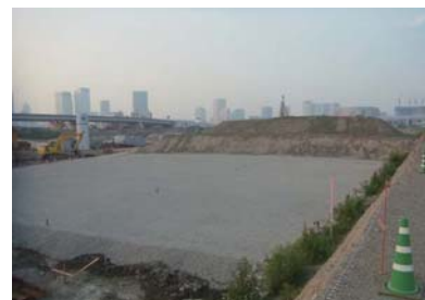
碎石層設置完了
