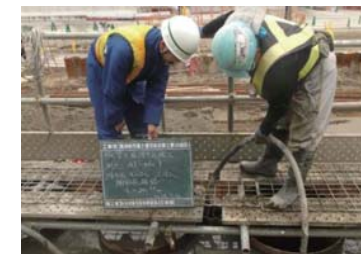
継手部充填材注入状況
