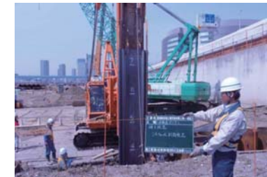
シートウォール建込み状況
