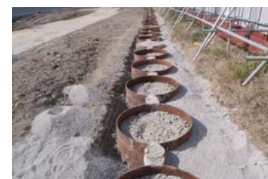
鋼管矢板遮水壁設置完了
