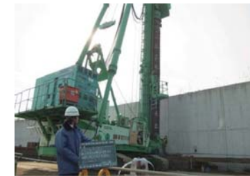
鋼管矢板打設状況(中掘り工法)(7 街区)
