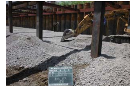
碎石敷き均し状況
