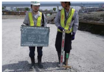
碎石層の高さ確認
