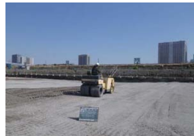
碎石転圧状況
