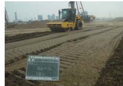
盛土転圧状況
