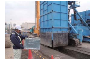
ソイルセメント壁造成状況(6 街区)
