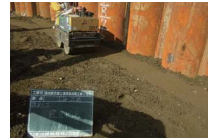
盛土転圧状況
