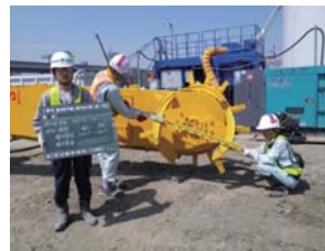
施工機械の確認
