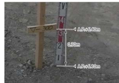
盛土高さ確認(拡大)
