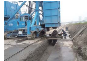
ソイルセメント壁造成状況(5 街区)
