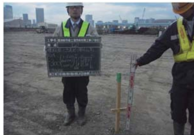
盛土高さ確認
