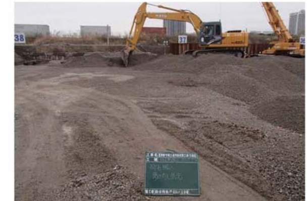
碎石敷き均し状況
