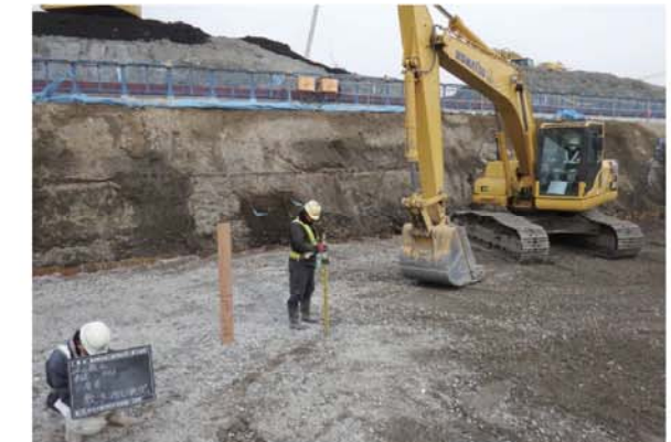
碎石敷き均し状況
