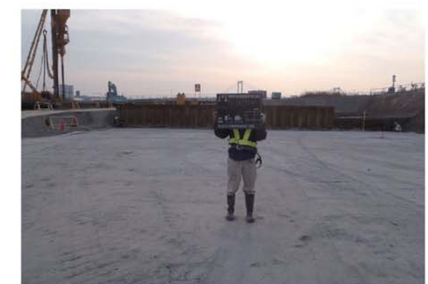
碎石層設置完了
