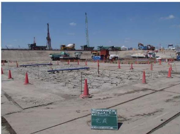
真空ドレーン設置状況
