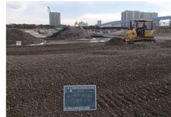
碎石敷き均し状況
