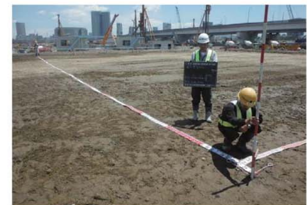
盛土完了（全景）
