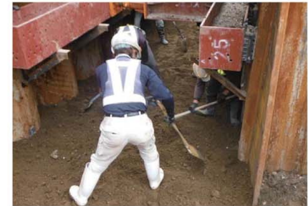
盛土敷均し状況
