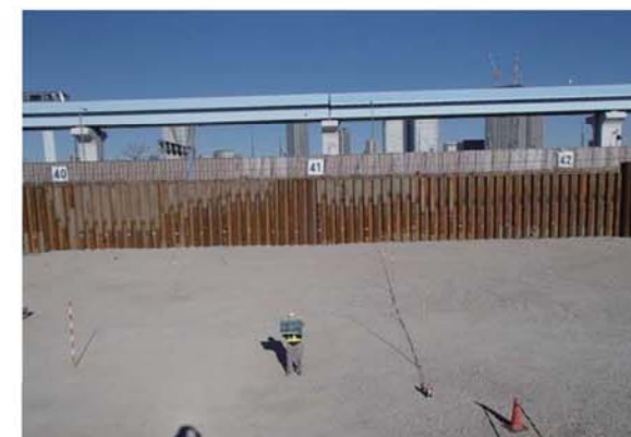
碎石層設置完了
