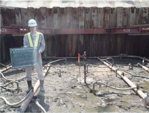
地下水対策完了確認
