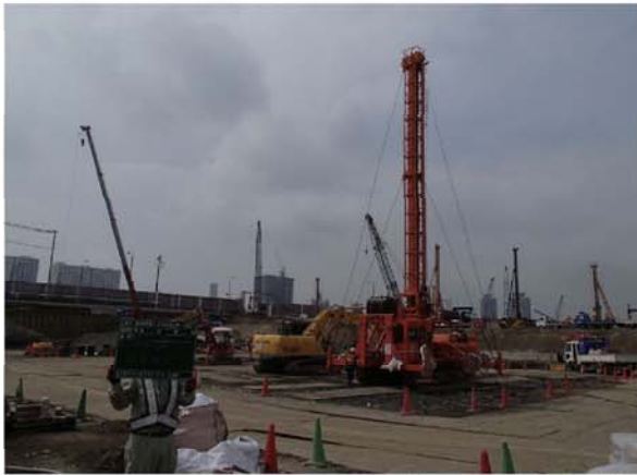
ドレーン材打設状況
