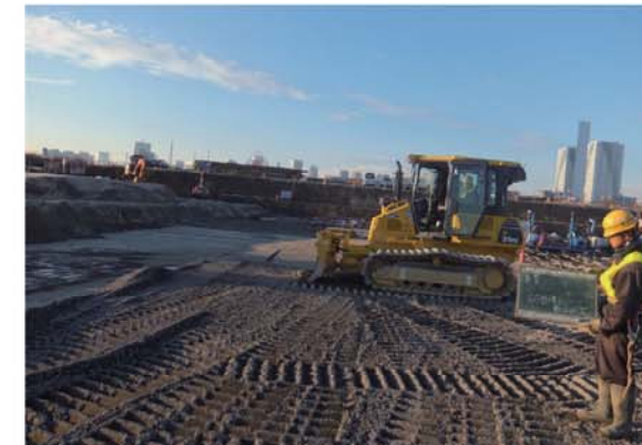
碎石敷き均し状況
