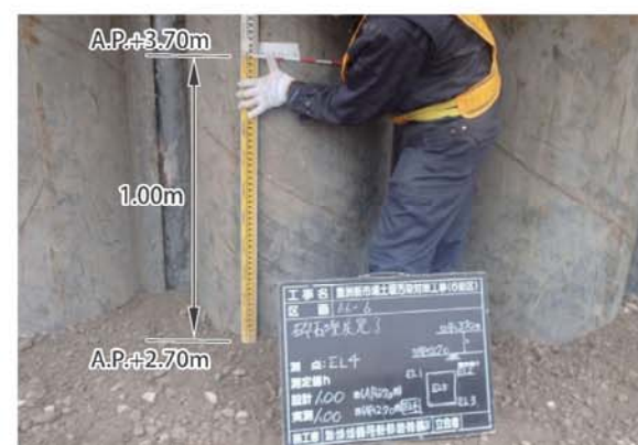
碎石層の高さ確認
