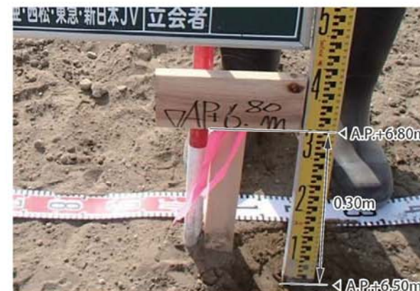
盛土高さの確認（拡大）
