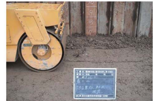
盛土転圧状況
