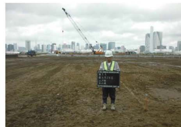
盛土完了（全景）
