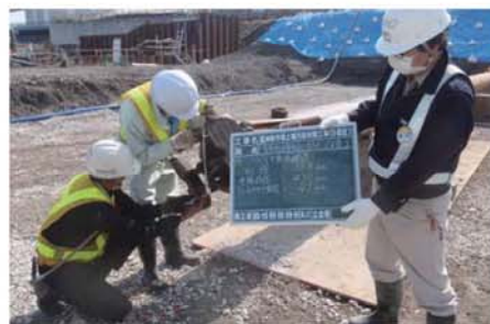
施工機械の確認
