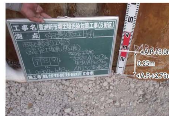
碎石層の高さ確認（拡大）
