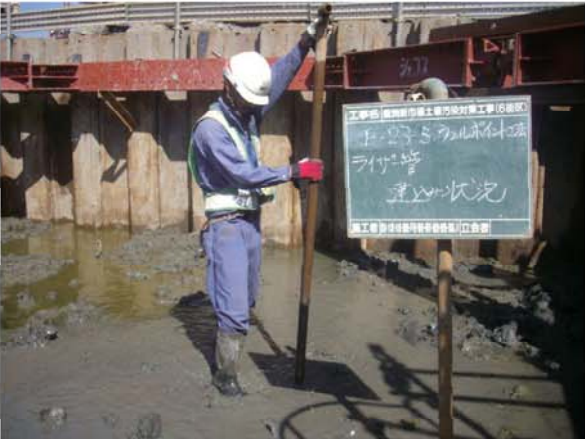
ウェルポイント設置状況
