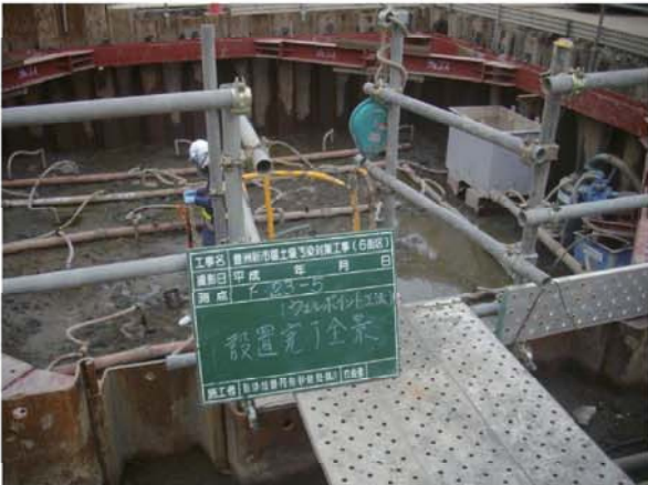
ウェルポイント設置状況
