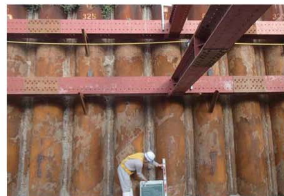
碎石層の高さ確認
