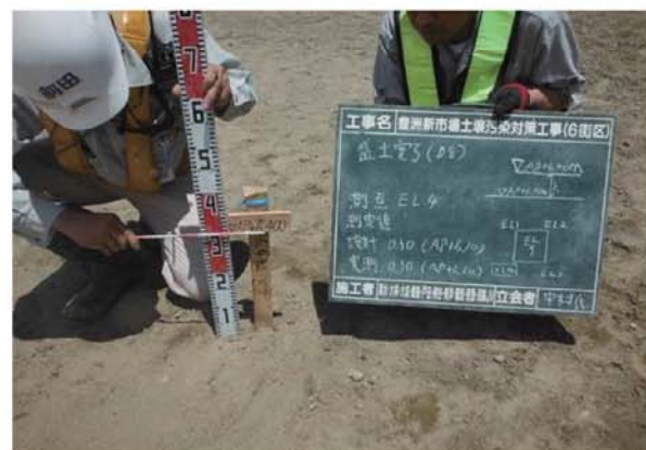
盛土高さの確認
