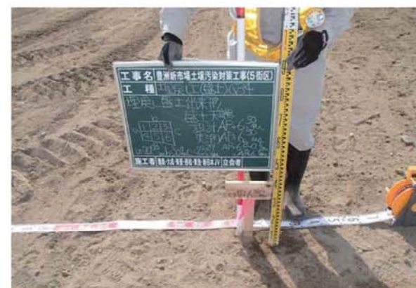
盛土高さの確認
