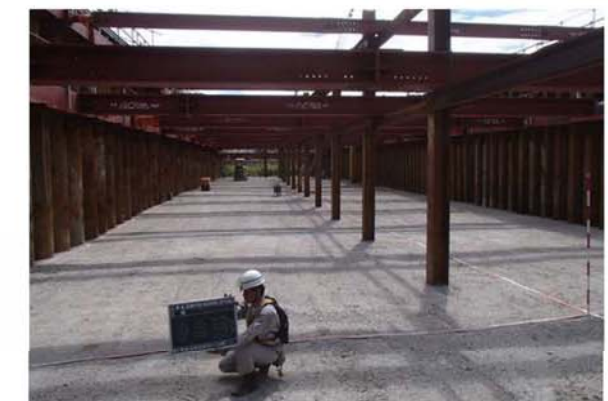
碎石層設置完了
