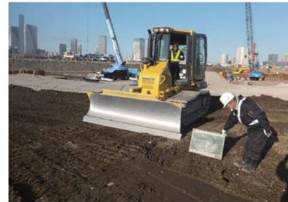
盛土敷均し状況
