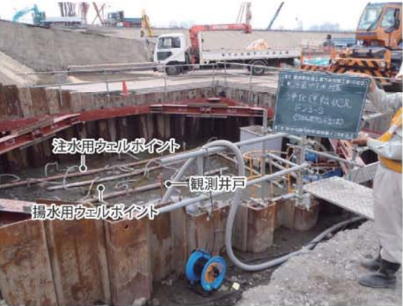
ウェルポイント運転状況
