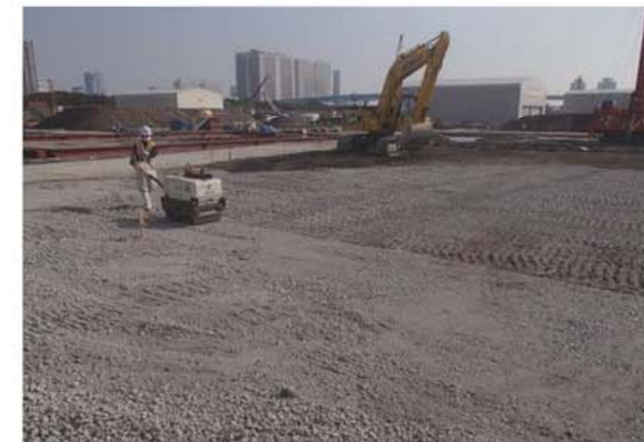
碎石転圧状況
