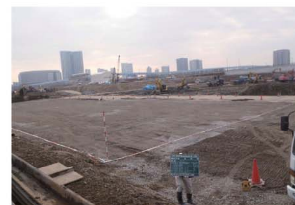
碎石層設置完了
