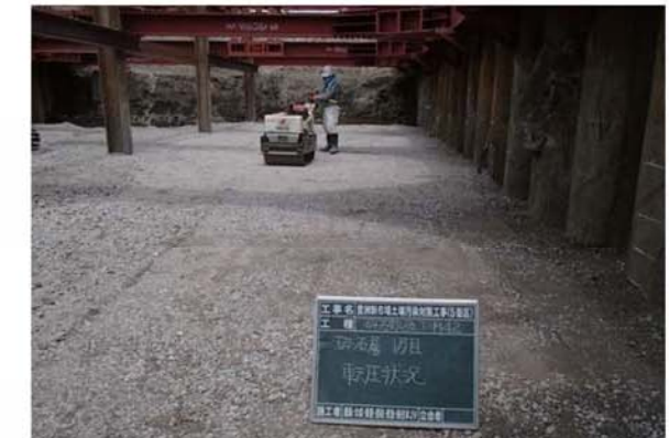
碎石転圧状況
