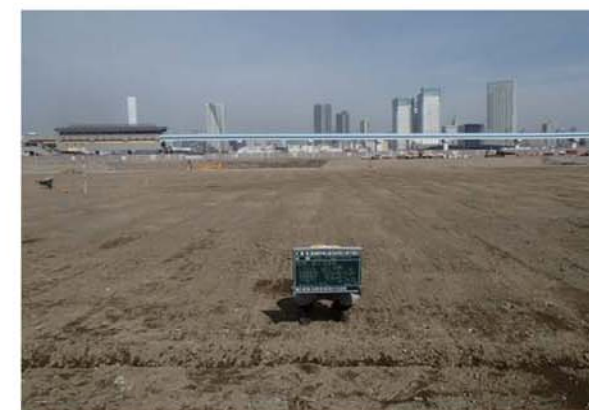
盛土完了（全景）
