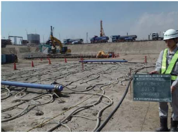
地下水対策完了確認
