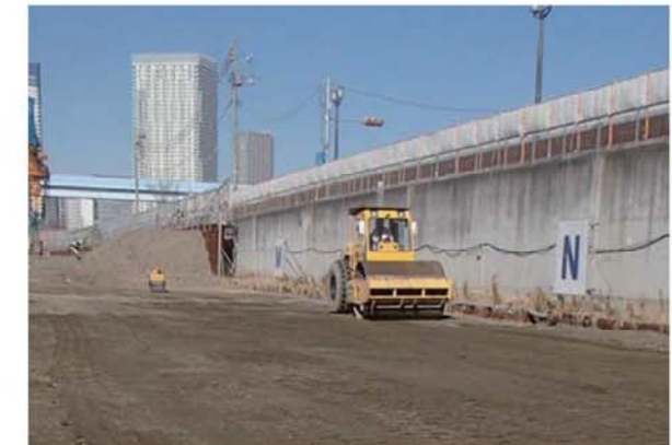
盛土転圧状況
