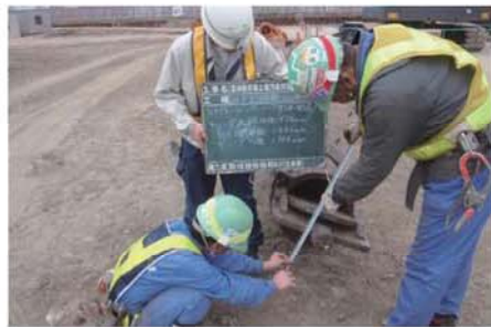
施工機械の確認
