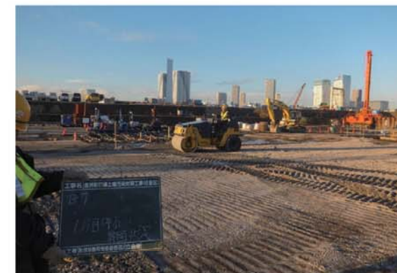
碎石転圧状況
