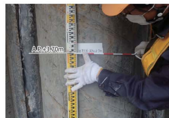
碎石層の高さ確認 (拡大)
