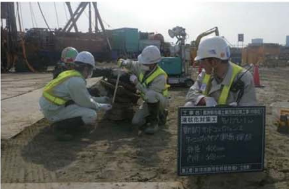
施工機械の確認
