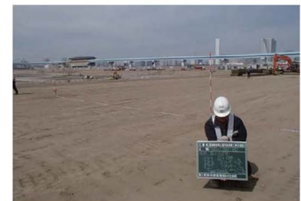
盛土完了（全景）
