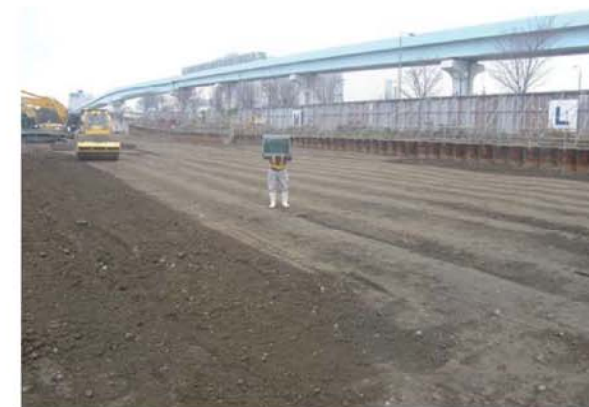
盛土転圧状況
