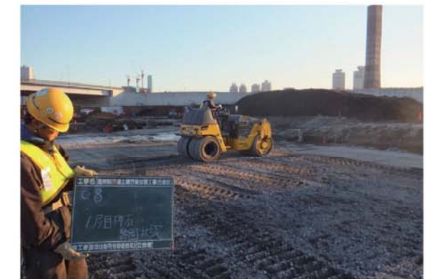
碎石転圧状況
