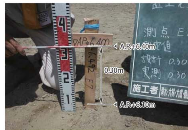
盛土高さの確認（拡大）
