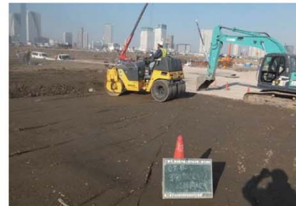
盛土転圧状況
