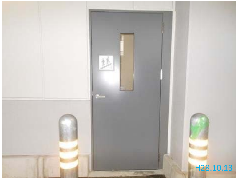
地下ピット連絡口(1階)
