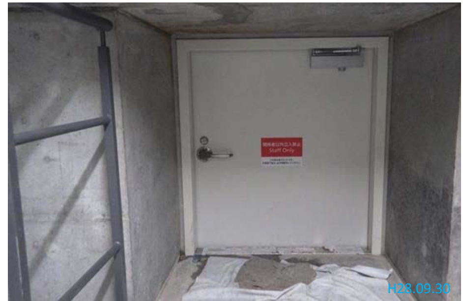
地下ピット出入口
