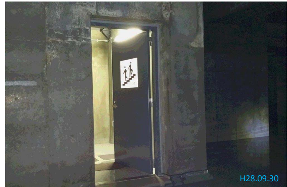
地下ピット出入口
