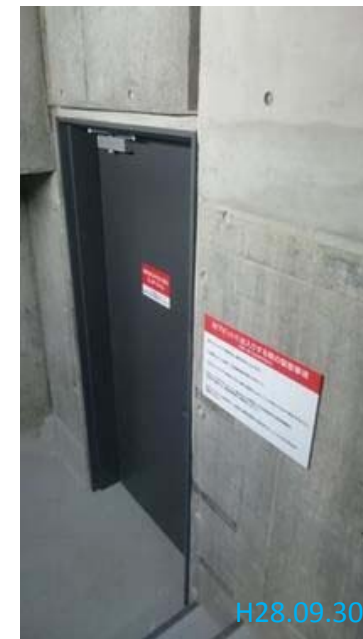
地下ピット出入口
