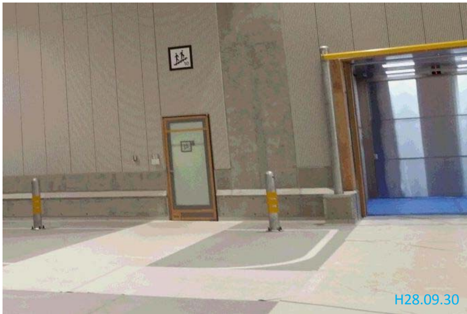
地下ピット連絡口(1階)
