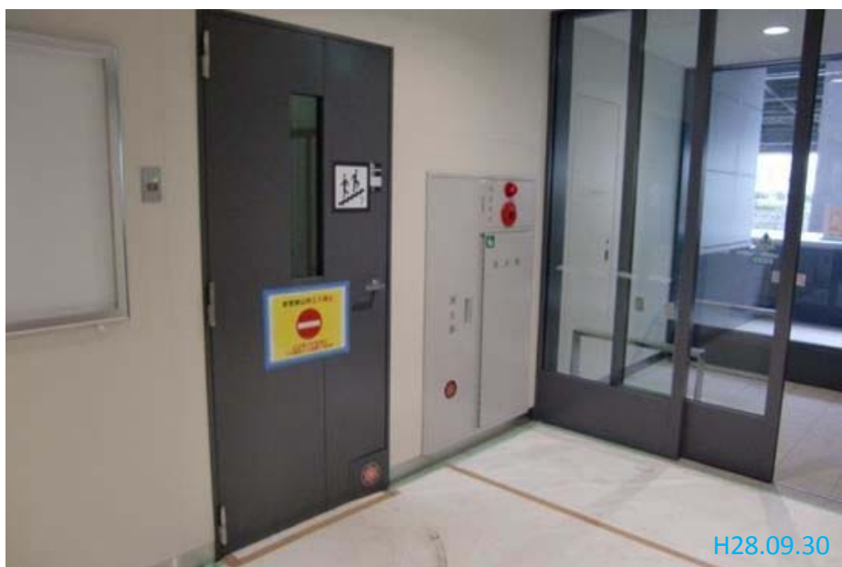
地下ピット連絡口(1階)
