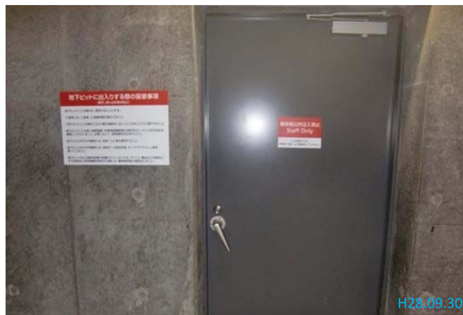
地下ピット出入口
