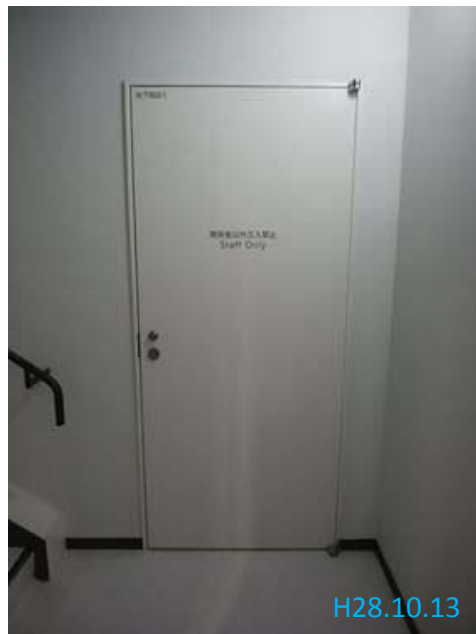
地下ピット連絡口(1階)
