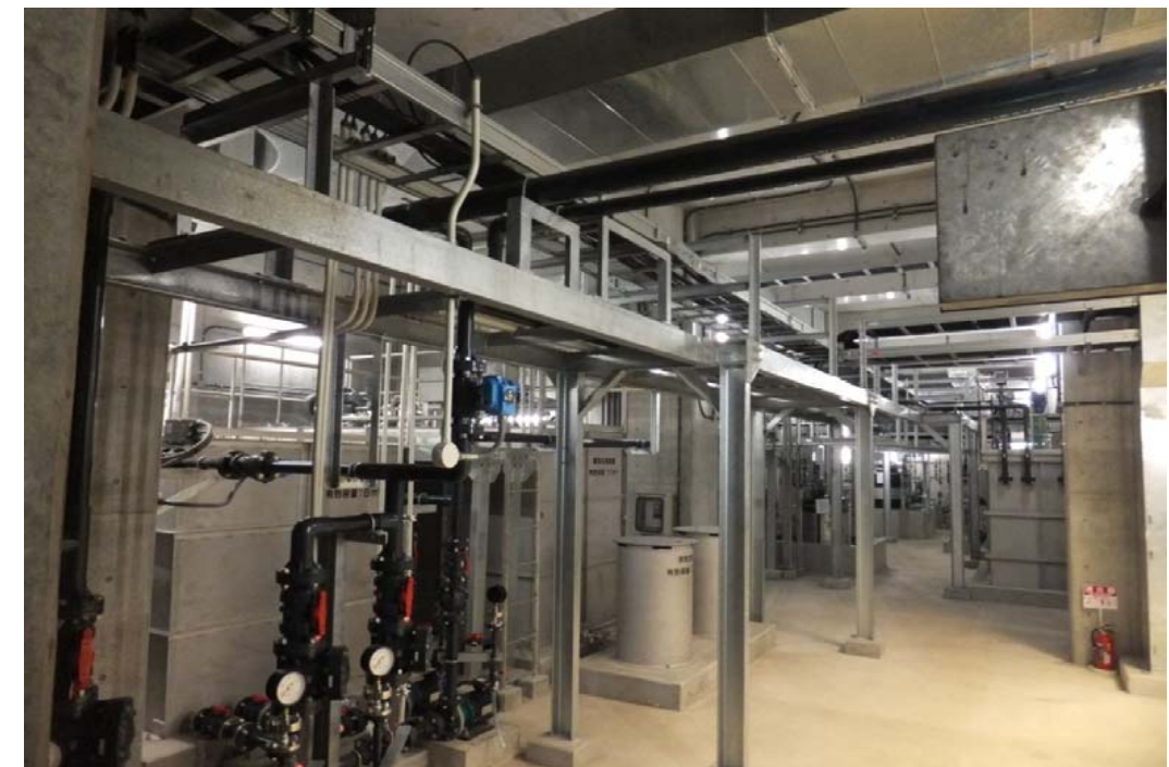
■排水施設棟 5街区
