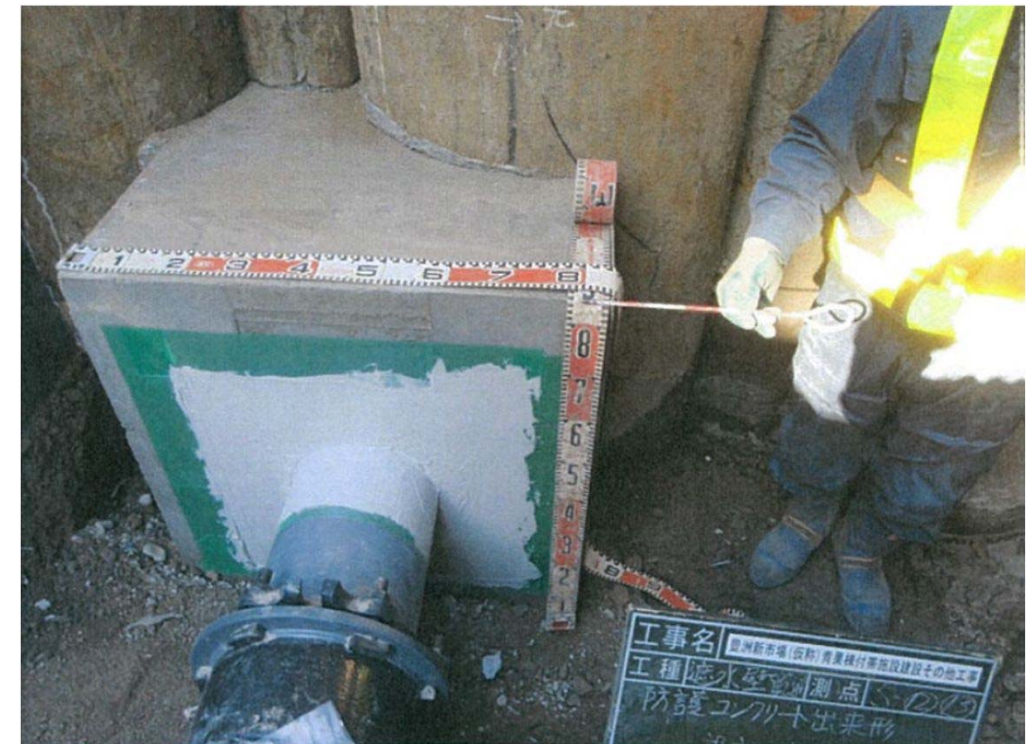
■遮水壁貫通部【5街区 青果東門污水管Φ250】
