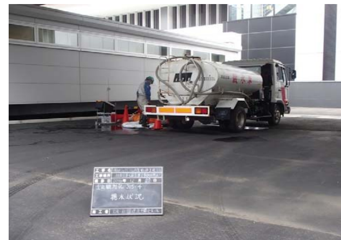
排水状況写真
