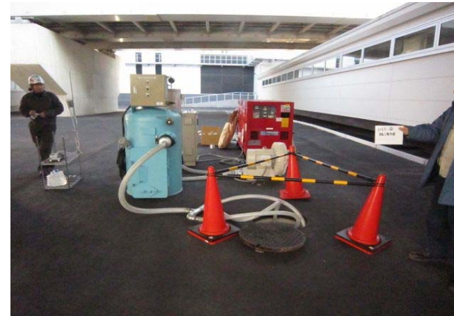
換気状況写真 (マンホール②)
