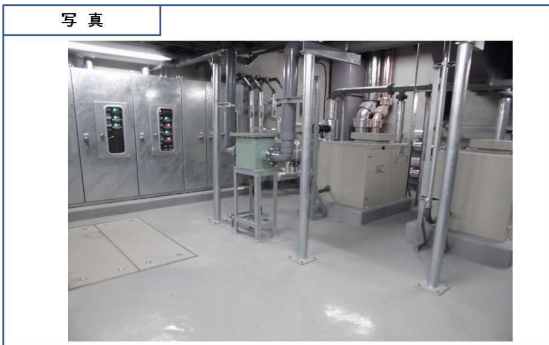
図 2. 4. 17(4) A. P. +2. 0m 以深に存在する構造物（水槽・ポンプ室（6 街区））（写真）
