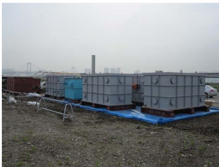
写真-5.1 高床式架設プラントと床面のブルーシート養生状況
