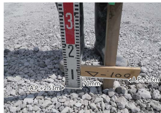
碎石層の高さ確認 (拡大)
