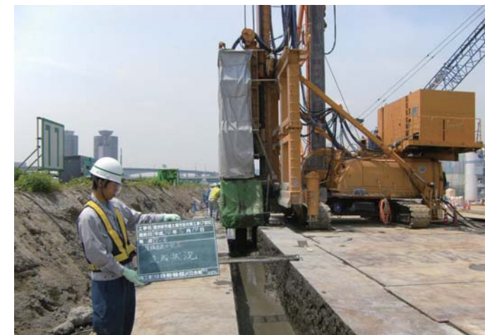
ソイルセメント壁造成状況 (7 街区)
