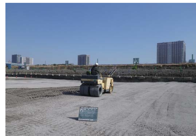
碎石転圧状況
