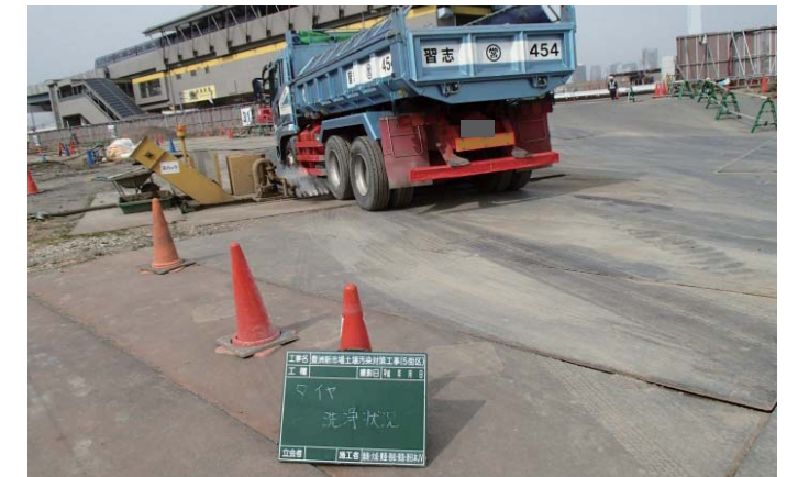
タイヤ洗浄状況
