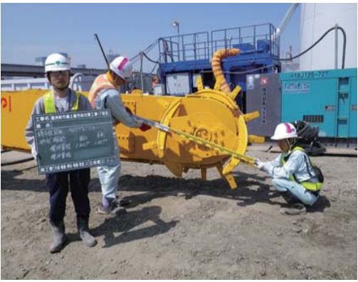
施工機械の確認
