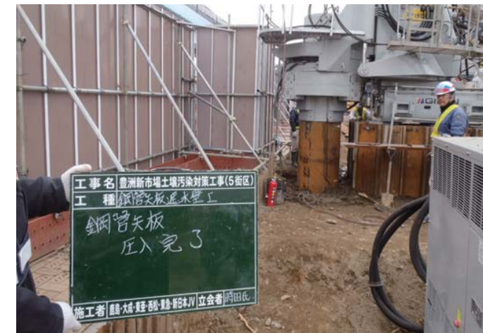
鋼管矢板打設状況 (圧入工法) (5 街区)
