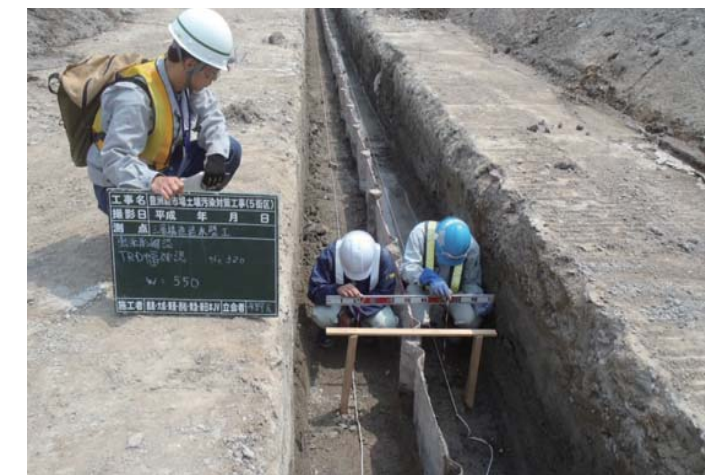
三層構造遮水壁設置完了
