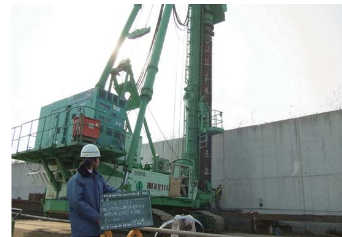
鋼管矢板打設状況 (中掘り工法) (7 街区)
