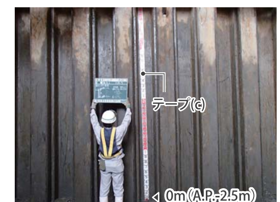
テープ(c)の下端0mを確認
