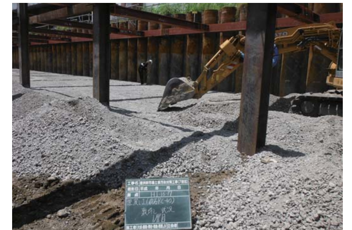
碎石敷き均し状況
