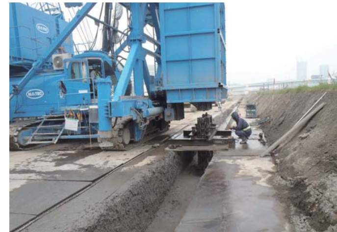
ソイルセメント壁造成状況 (5 街区)
