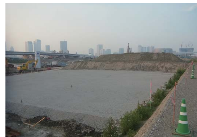
碎石層設置完了
