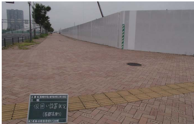
仮囲い設置状況
