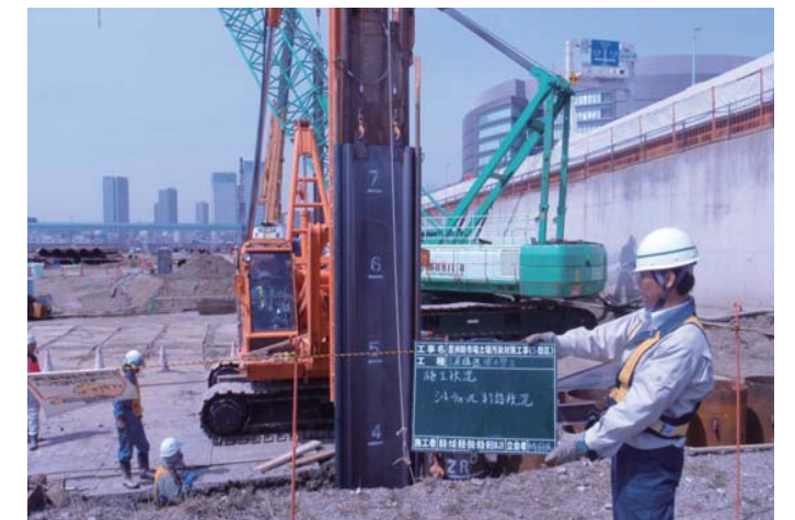
シートウォール建込み状況
