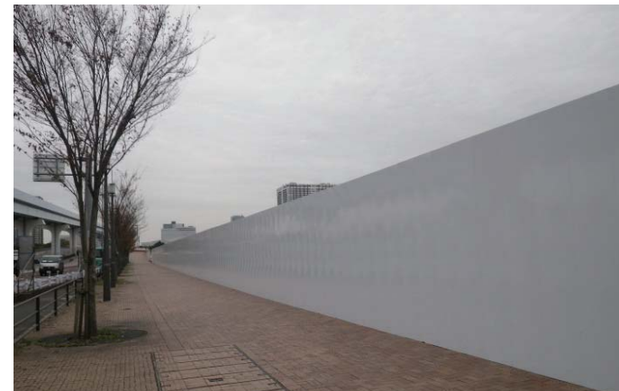
仮囲い設置状況
