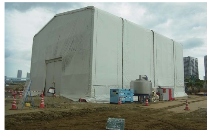
テント設置状況
