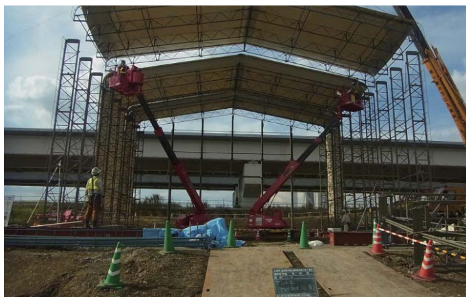
テント設置状況
