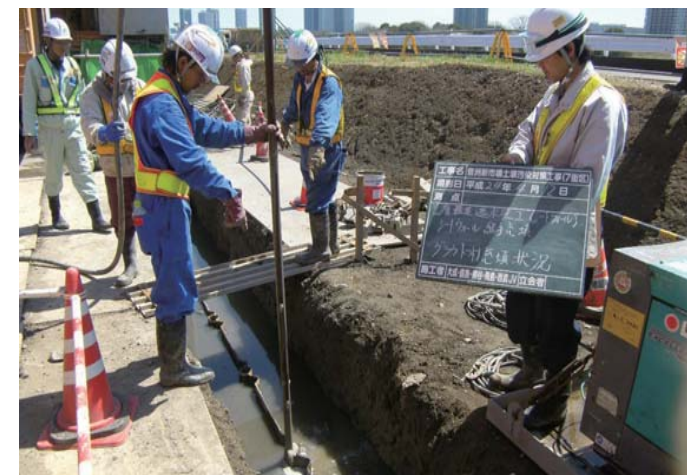
継手部充填材注入
