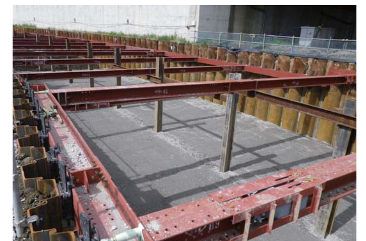
碎石層設置完了
