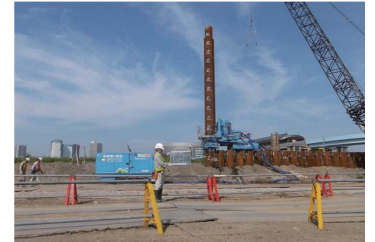
鋼管矢板打設状況 (圧入工法) (6 街区)
