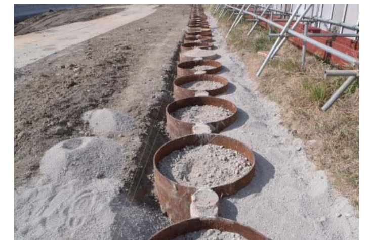
鋼管矢板遮水壁設置完了
