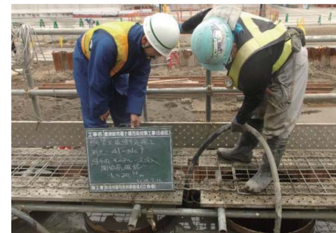
継手部充填材注入状況
