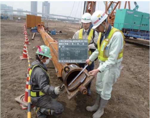
施工機械の確認
