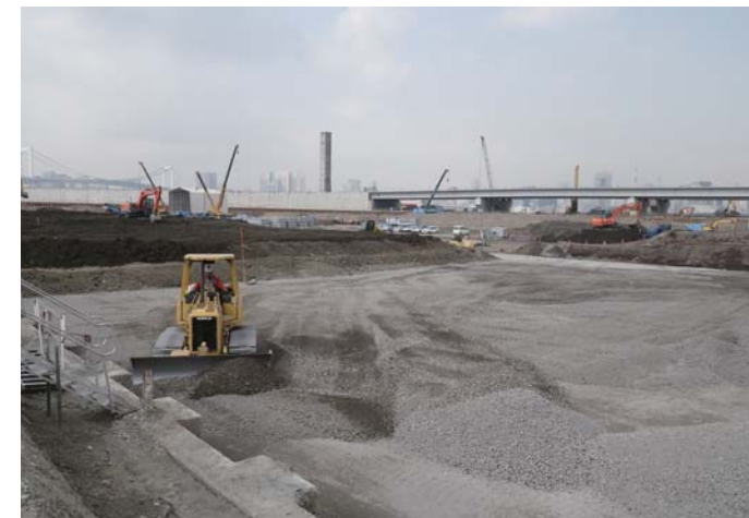
碎石敷き均し状況
