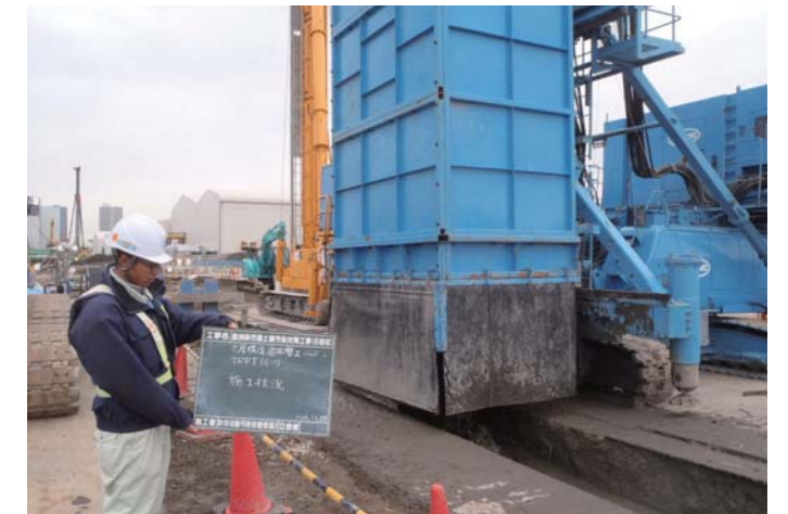
ソイルセメント壁造成状況 (6 街区)
