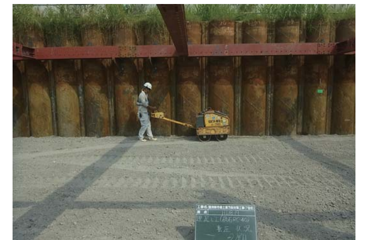
碎石転圧状況
