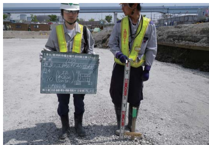
碎石層の高さ確認
