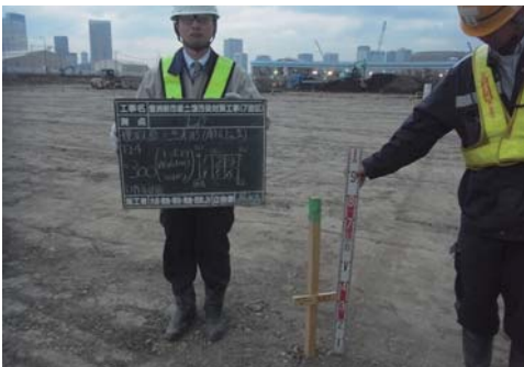
盛土高さの確認
