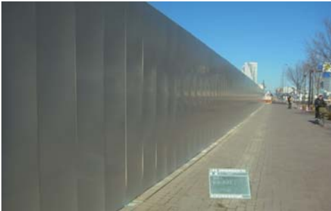
仮囲い設置状況
