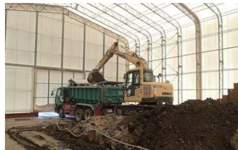
密閉式ダンプ車の使用
