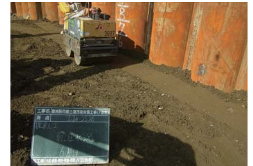
盛土転圧状況
