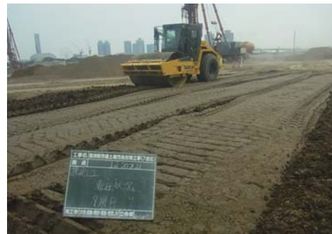
盛土転圧状況
