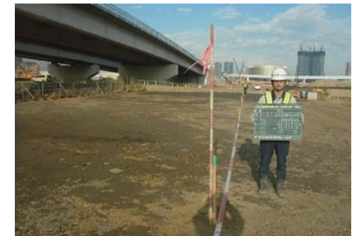
盛土完了(全景)
