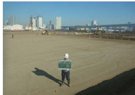
盛土完了(全景)
