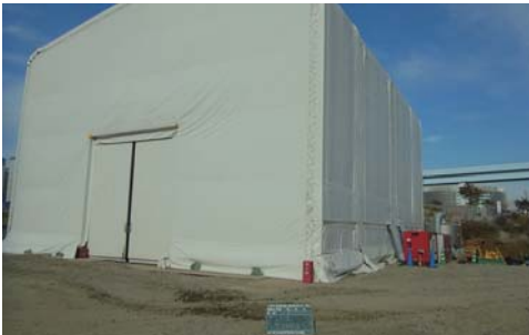
テント設置状況
