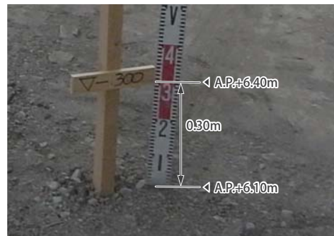
盛土高さの確認(拡大)
