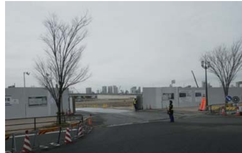
出入口ゲート
