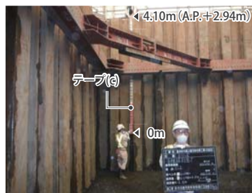
テープ(c)による基準高4.10mを確認
