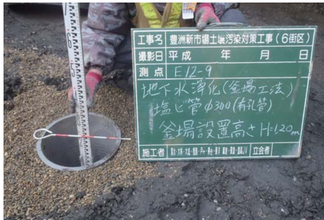
釜場設置状況
