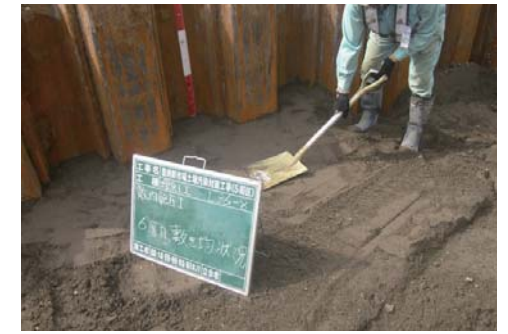
埋め戻し土 敷均し状況
