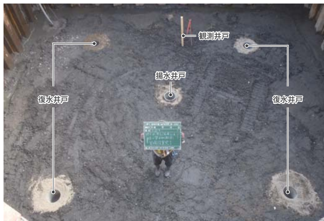
釜場設置完了
