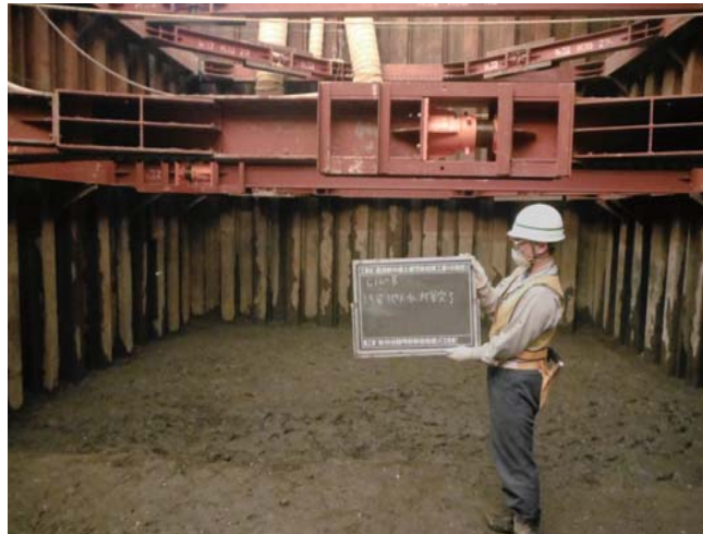
対策完了確認（掘削除去）
