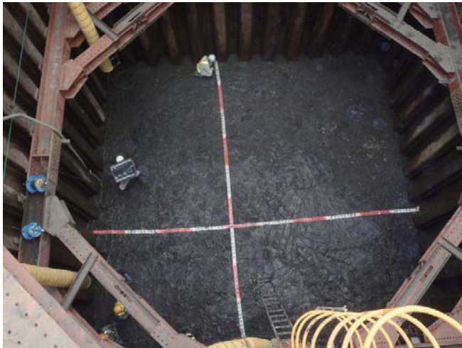
対策完了確認（掘削除去）
