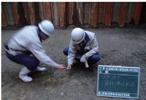
掘削底面の確認状況
