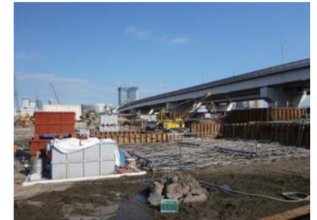
真空ドレーン設置状況
