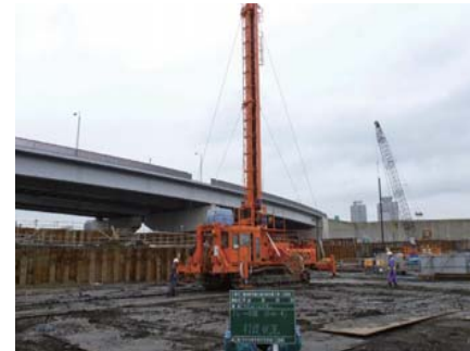
ドレーン材打設状況
