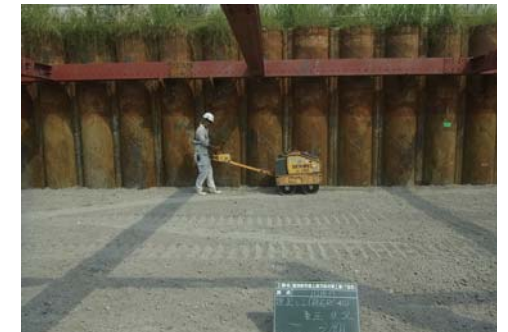
砕石転圧状況
