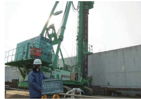
鋼管矢板打設状況(中掘り工法)(7街区)
