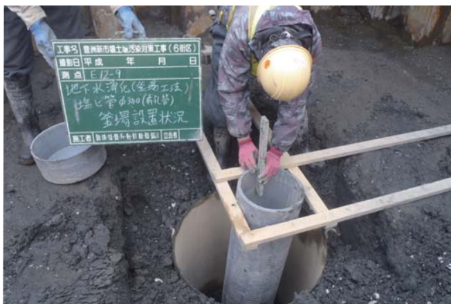
釜場設置状況
