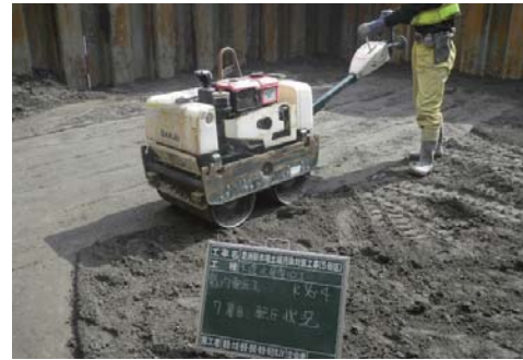
ベントナイト混合土 転圧状況
