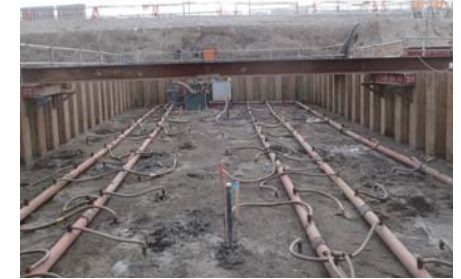
ウェルポイント設置状況
