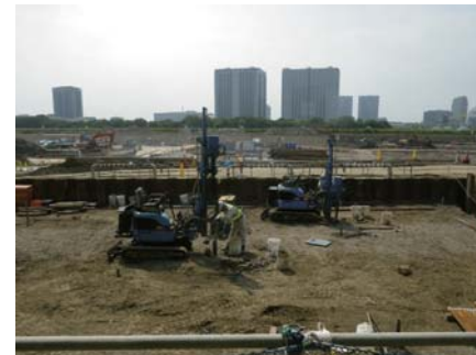
スパーキング井戸設置状況
