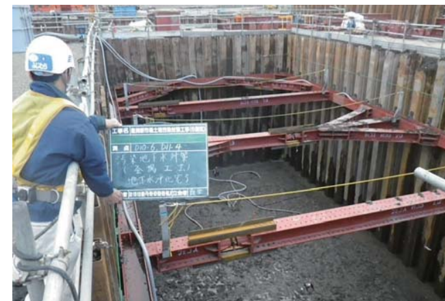
地下水対策完了確認
