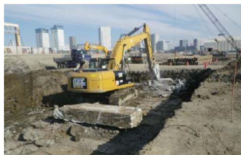
地中障害物解体状況
