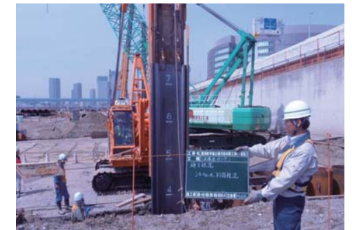
シートウォール建込み状況
