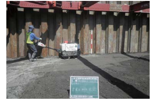
埋め戻し土 転圧状況
