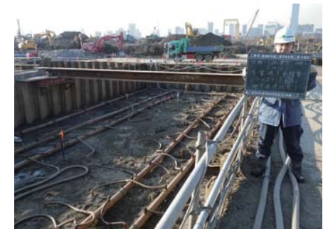
地下水対策完了確認
