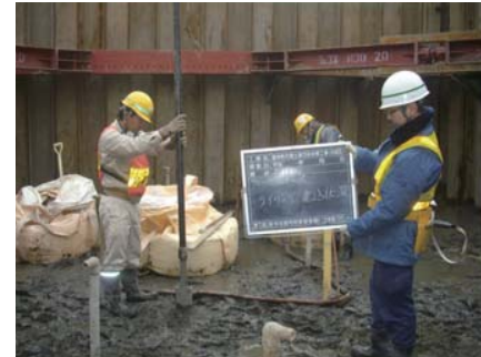
ウェルポイント設置状況
