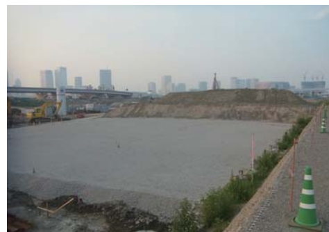
砕石層設置完了
