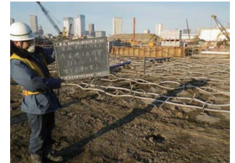
地下水対策完了確認
