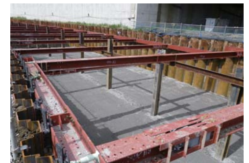
砕石層設置完了
