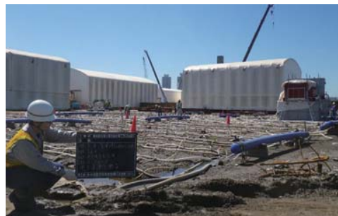
対策完了確認
