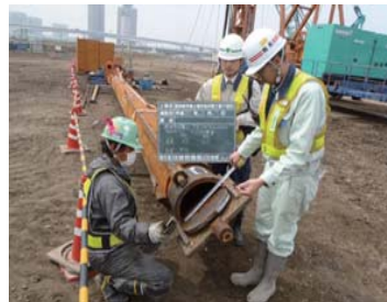
施工機械の確認
