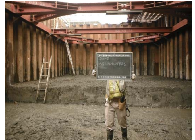
対策完了確認（掘削除去）
