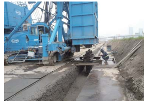
ソイルセメント壁造成状況 (5街区)
