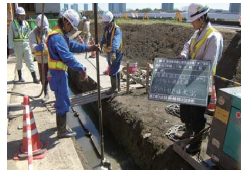
継手部充填材注入
