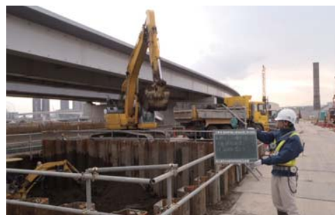
土壌積み込み状況
