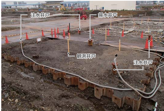
ディープウェル工法運転状況
