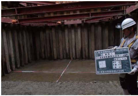
掘削底面の確認状況
