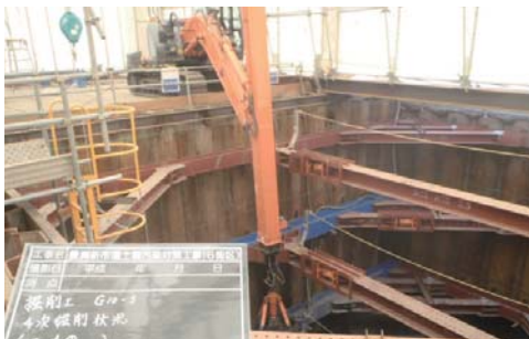
テント内掘削状況
