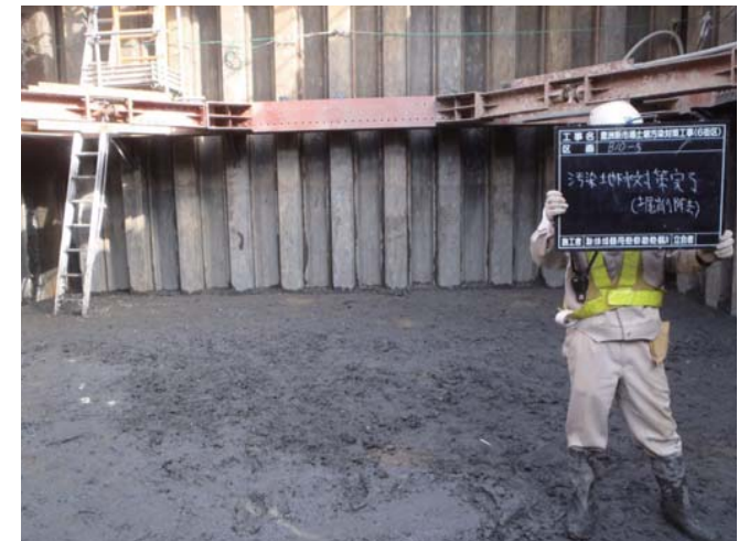
対策完了確認（掘削除去）
