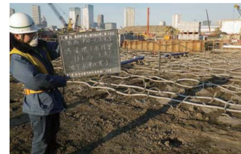
対策完了確認
