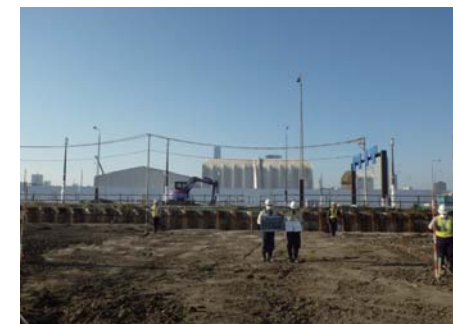
地下水対策完了確認
