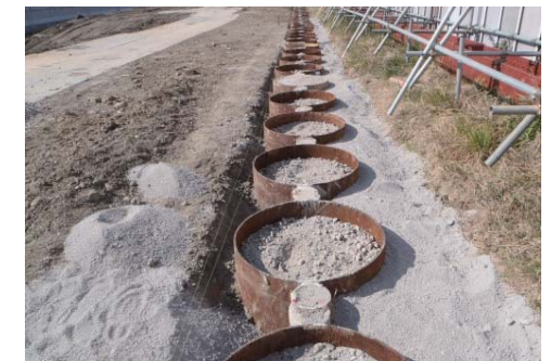
鋼管矢板遮水壁設置完了
