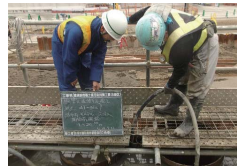
継手部充填材注入状況
