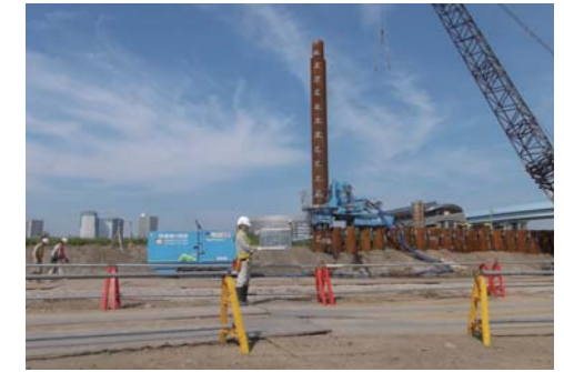
鋼管矢板打設状況(圧入工法)(6街区)
