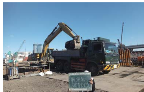
土壌積み込み状況
