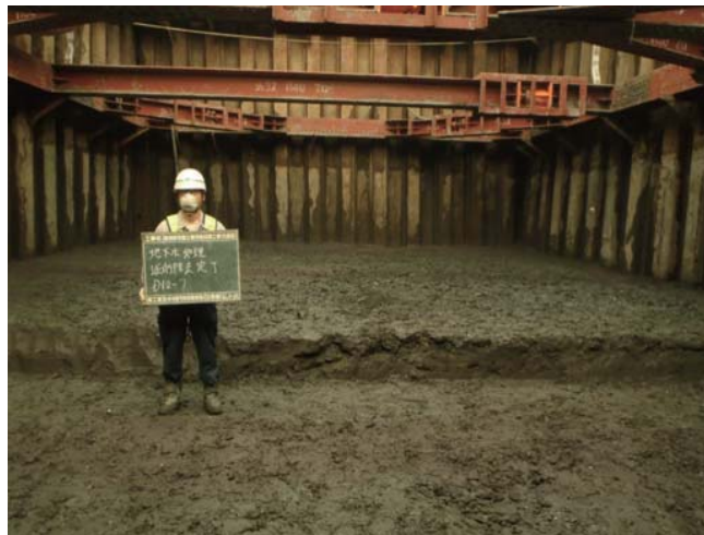
対策完了確認（掘削除去）
