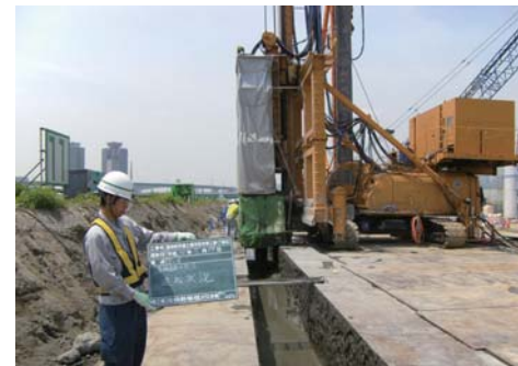
ソイルセメント壁造成状況 (7街区)
