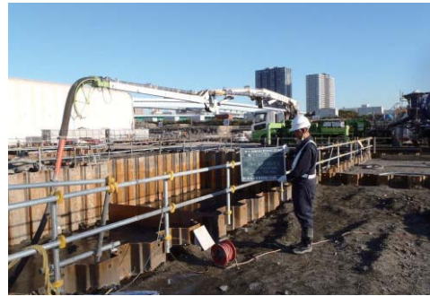
流動化処理土 打設状況
