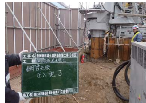
鋼管矢板打設状況(圧入工法)(5街区)
