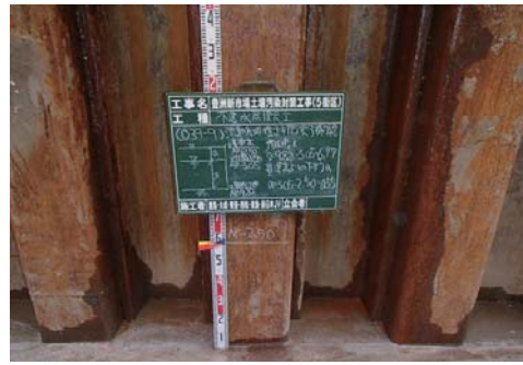
流動化処理土 打設完了
