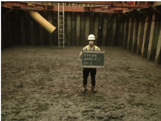
対策完了確認（掘削除去）
