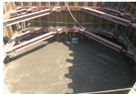
ベントナイト施工完了
