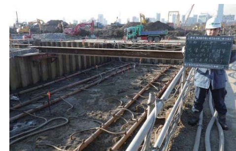
対策完了確認
