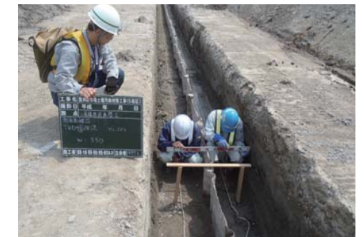
三層構造遮水壁設置完了
