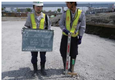
砕石層の高さ確認
