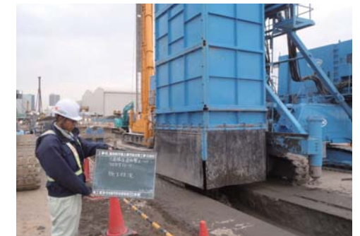
ソイルセメント壁造成状況 (6街区)
