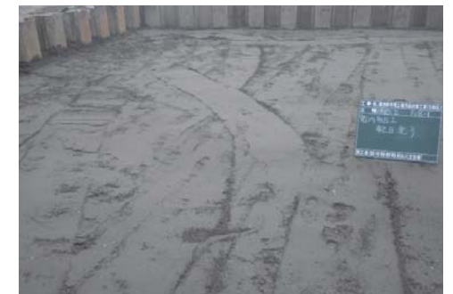
埋め戻し完了
