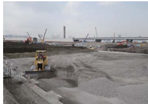
砕石敷き均し状況
