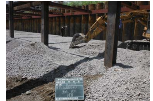
砕石敷き均し状況
