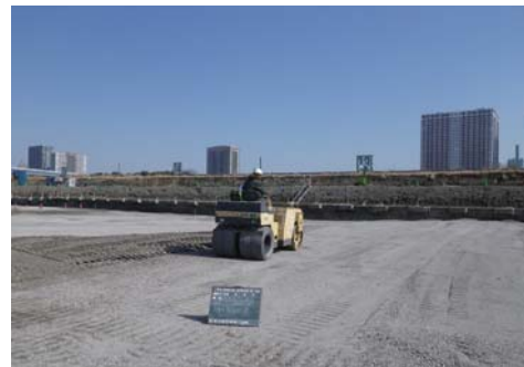
砕石転圧状況
