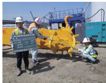
施工機械の確認
