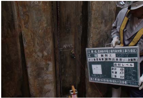
掘削底面の確認状況
