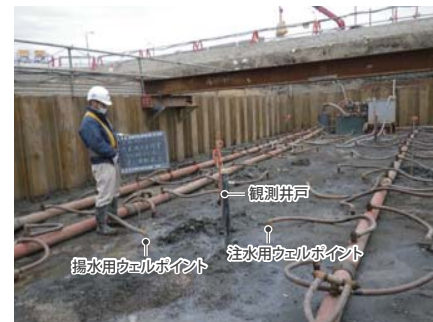
ウェルポイント運転状況
