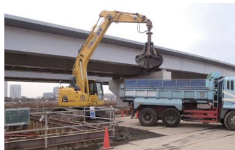
土壌積み込み状況
