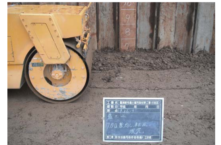
盛土転圧状況
