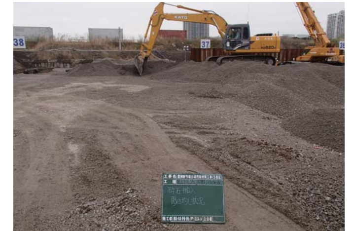
砕石敷き均し状況
