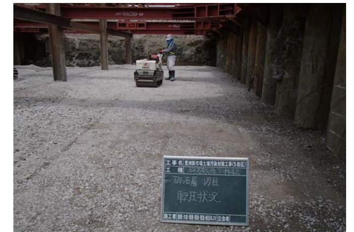
砕石転圧状況
