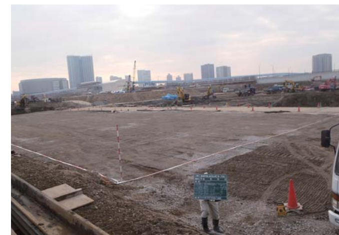
砕石層設置完了
