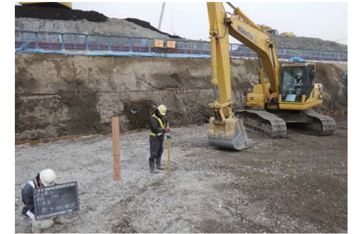
砕石敷き均し状況
