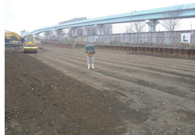
盛土転圧状況
