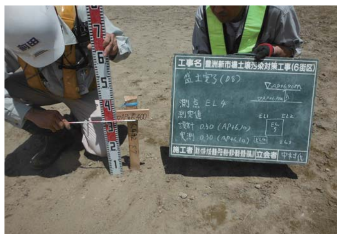
盛土高さの確認
