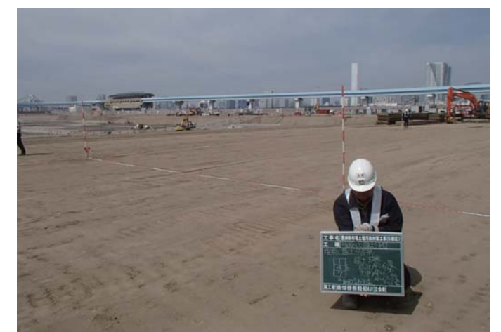
盛土完了 (全景)
