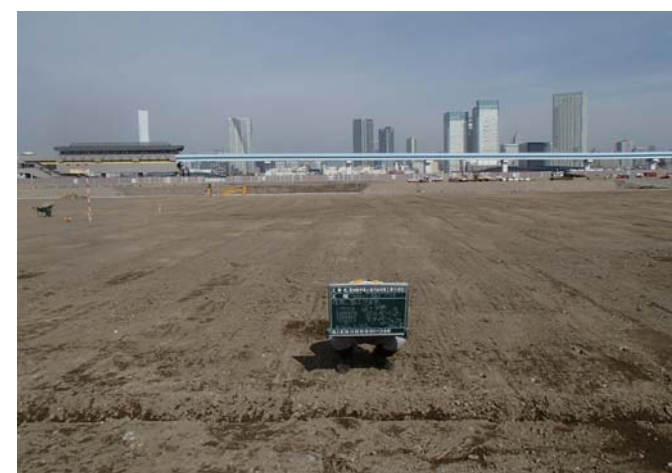
盛土完了 (全景)
