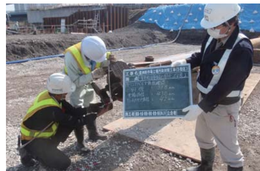
施工機械の確認
