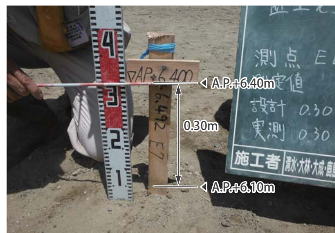
盛土高さの確認(拡大)
