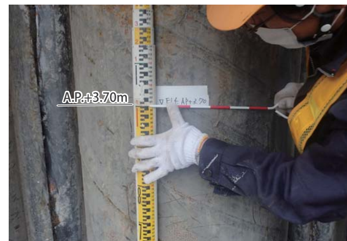
砕石層の高さ確認 (拡大)
