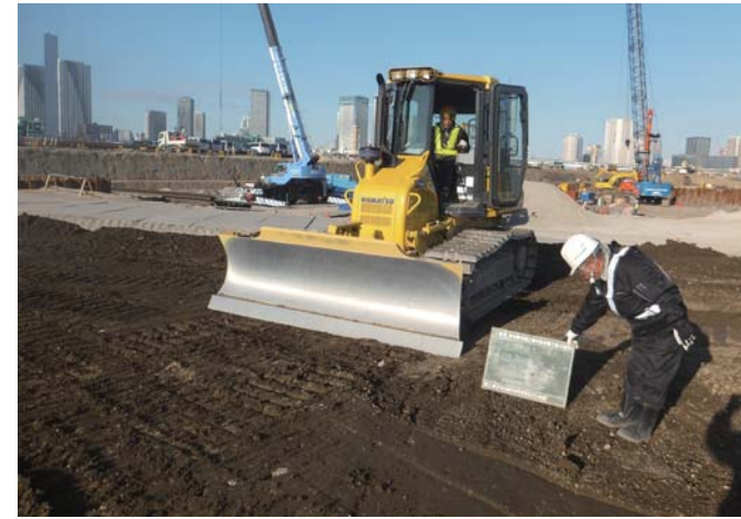
盛土敷均し状況
