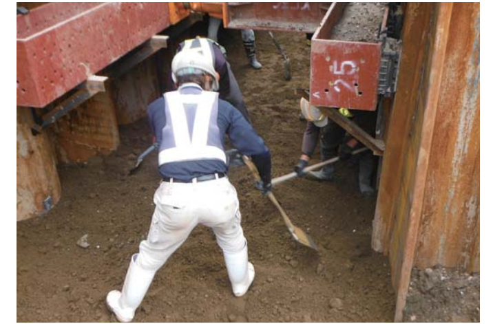
盛土敷均し状況
