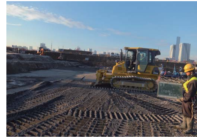
砕石敷き均し状況
