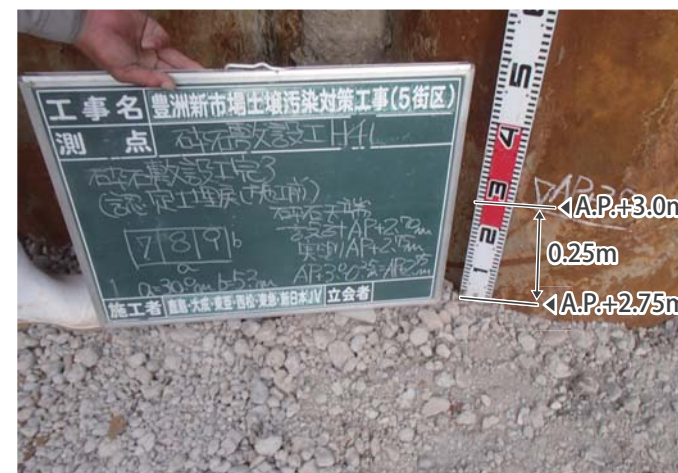
砕石層の高さ確認 (拡大)
