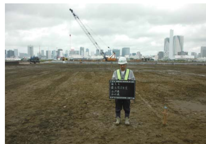
盛土完了(全景)
