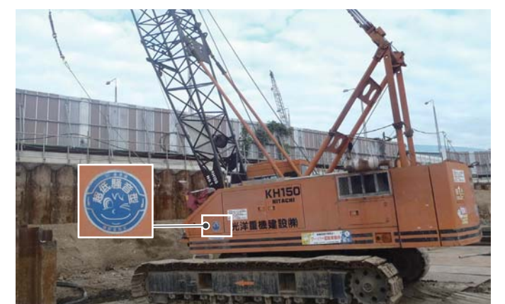
クローラークレーン(低騒音型認定、排ガス対策型認定)
