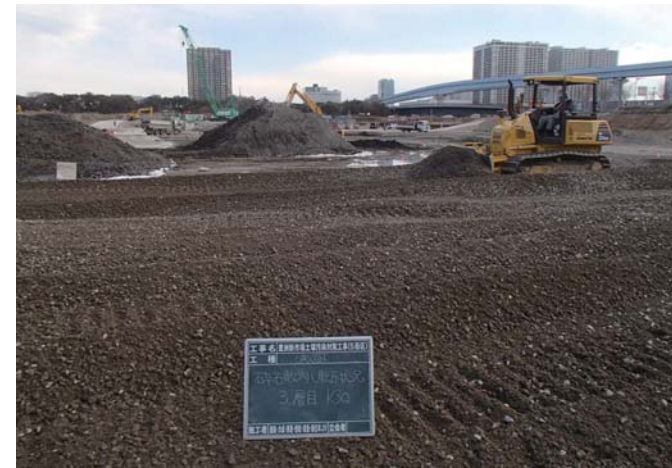
砕石敷き均し状況
