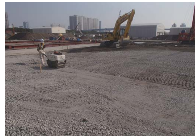
砕石転圧状況
