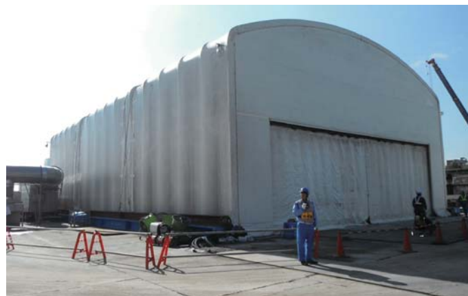
テント設置状況
