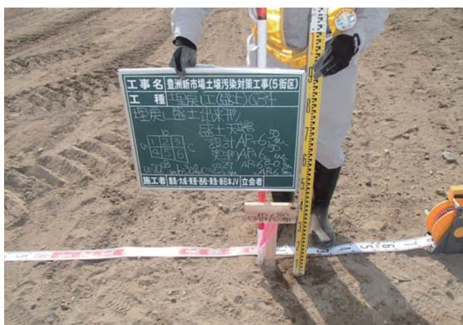
盛土高さの確認
