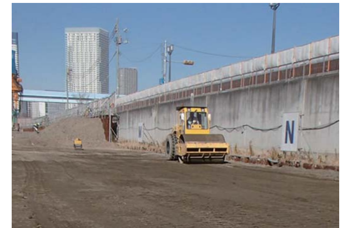
盛土転圧状況
