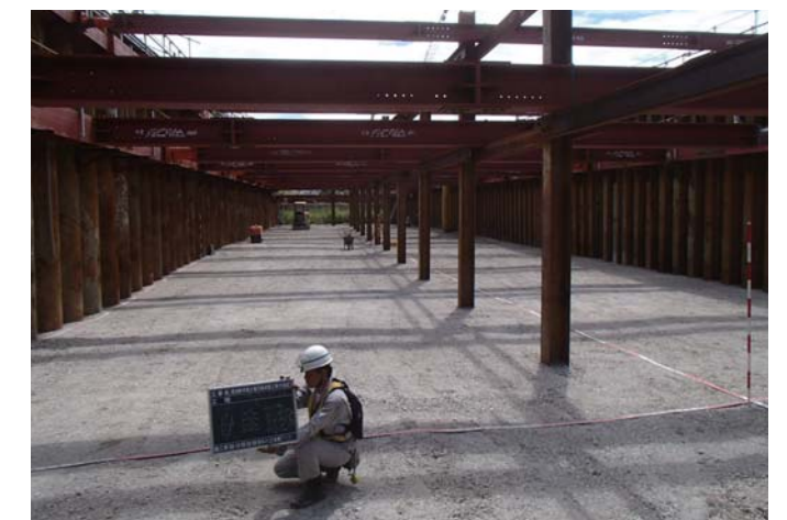
砕石層設置完了
