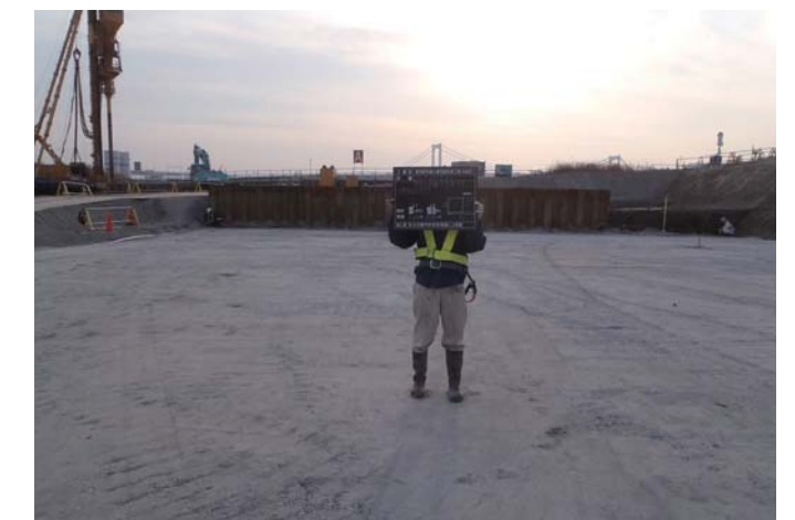
砕石層設置完了
