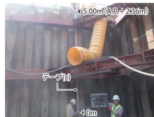
テープ(c)による基準高5.00mを確認
