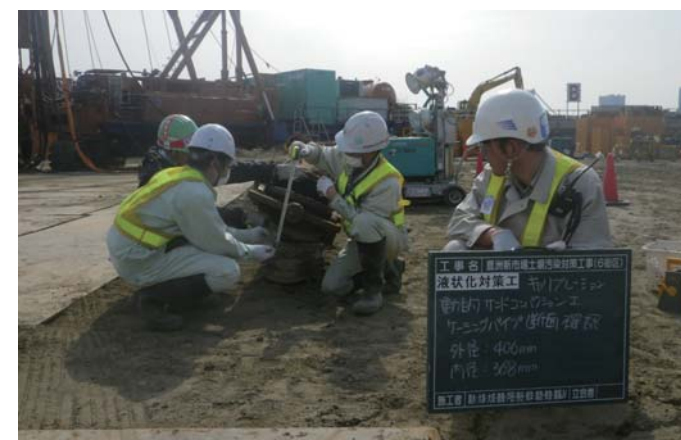
施工機械の確認
