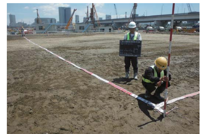
盛土完了(全景)
