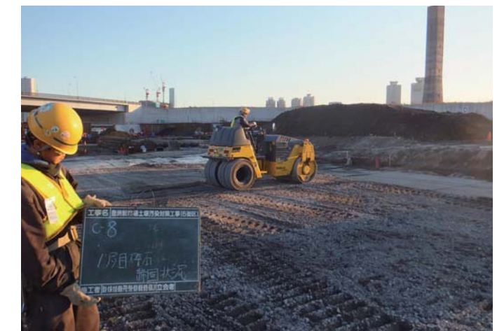
砕石転圧状況
