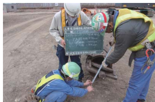
施工機械の確認
