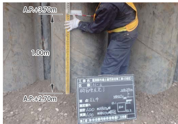
砕石層の高さ確認
