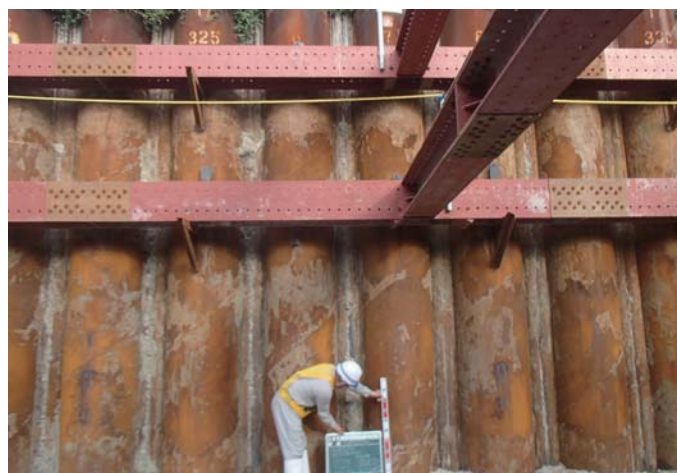
砕石層の高さ確認
