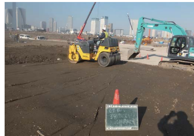
盛土転圧状況
