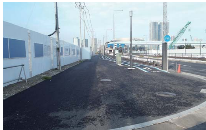
仮囲い設置状況
