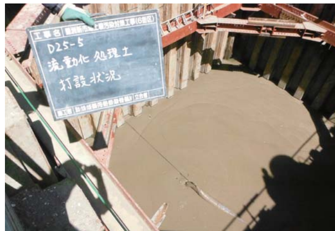
流動化処理土 打設状況
