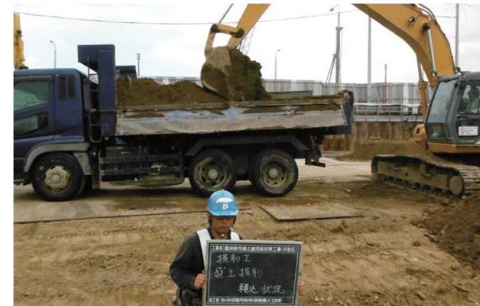
土壌積み込み状況
