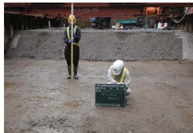
埋め戻し完了
