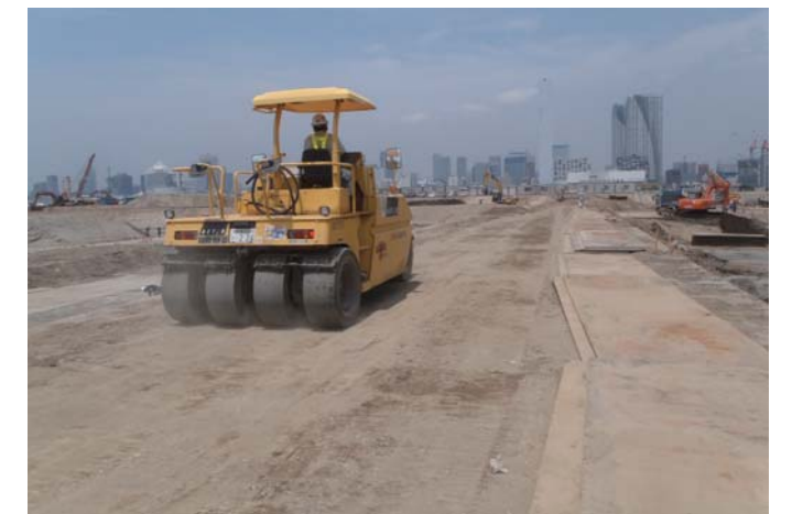
盛土 転圧状況
