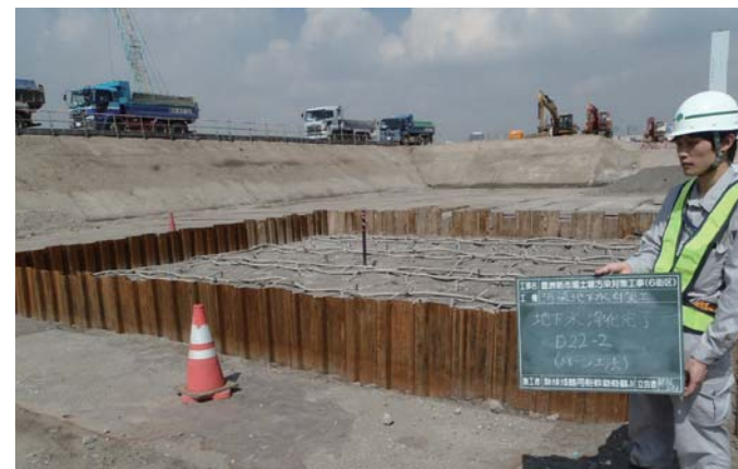
対策完了確認
