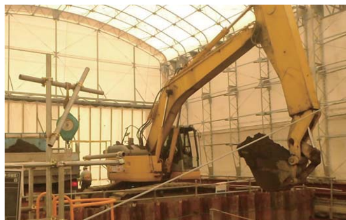
テント内掘削状況
