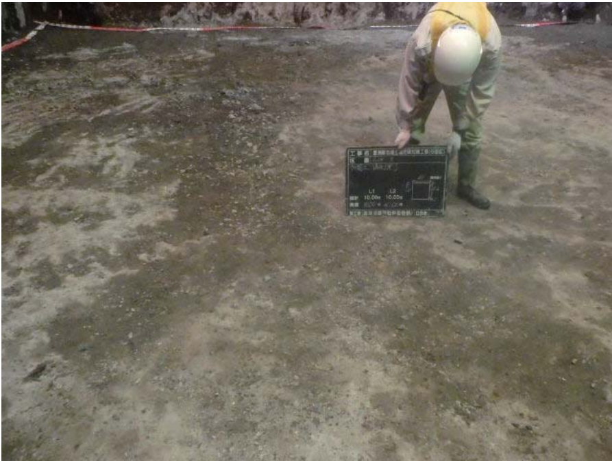
対策完了確認 (掘削除去)
