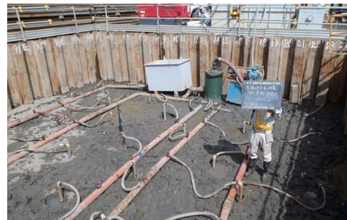
対策完了確認
