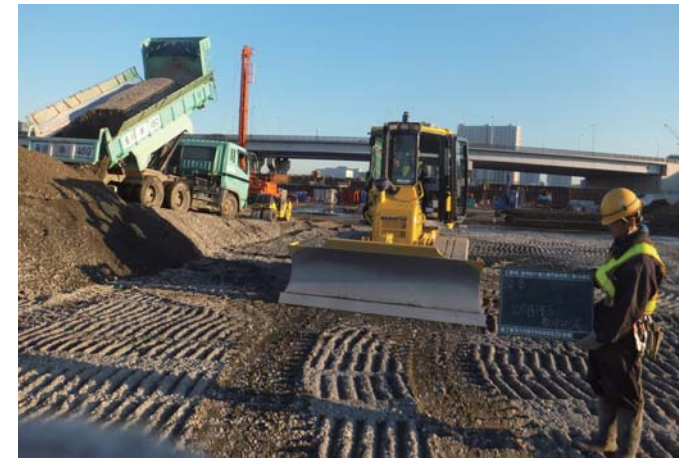
砕石 敷均し状況
