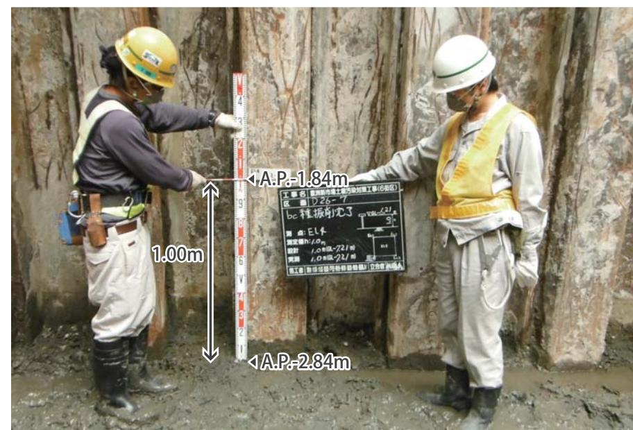
対策深さ確認
