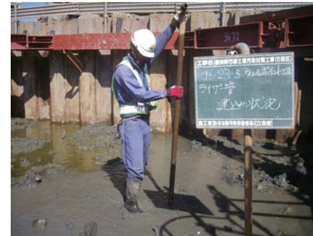
ウェルポイント設置状況
