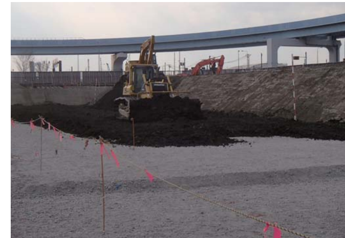
盛土 敷均し状況
