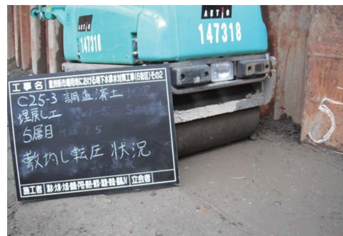
埋め戻し土 転圧状況
