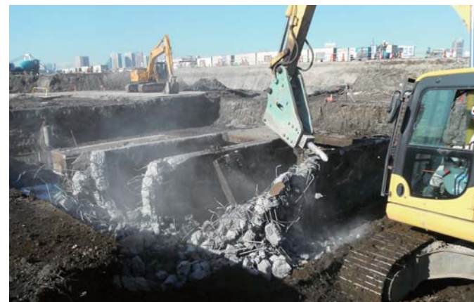
地中障害物解体状況
