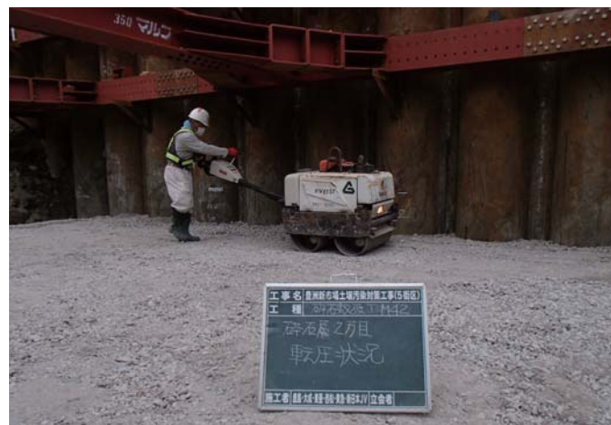
砕石転圧状況
