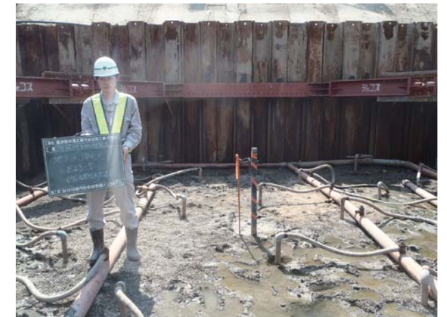
地下水対策完了確認
