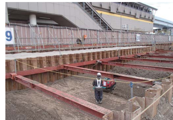
盛土 転圧状況
