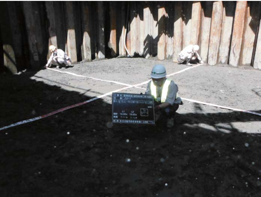
対策完了確認 (掘削除去)
