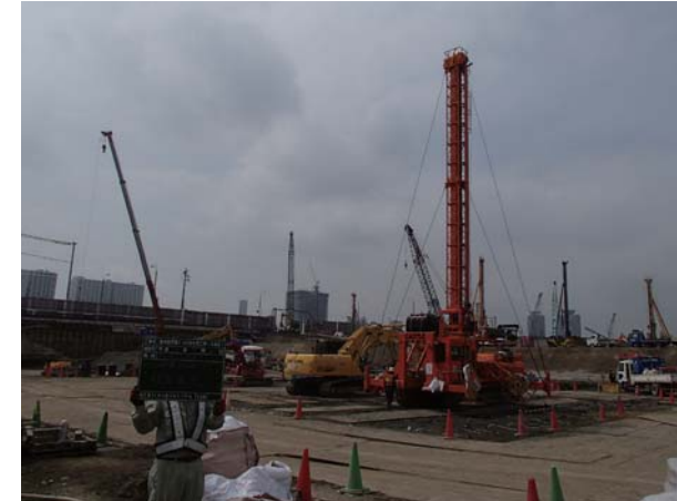
ドレーン材打設状況
