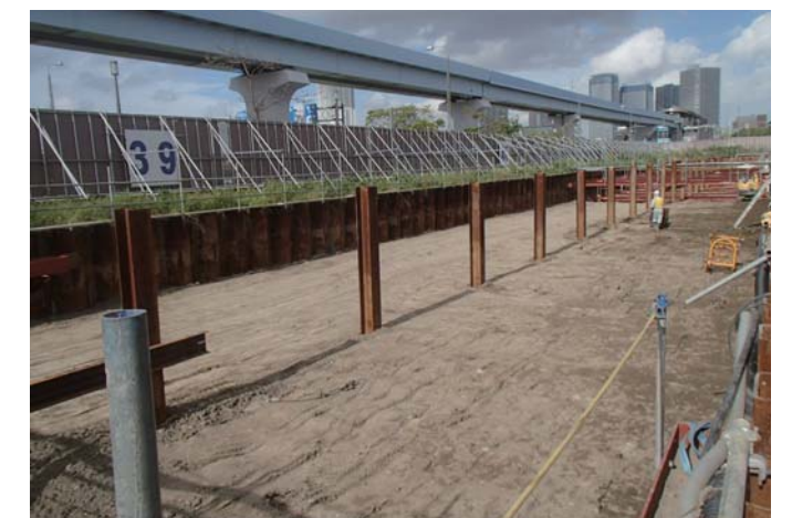
盛土 転圧状況
