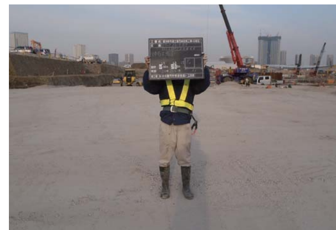
砕石層設置完了
