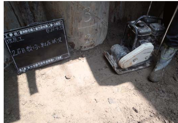
埋め戻し土 転圧状況
