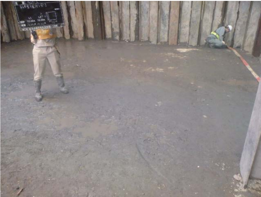
対策完了確認 (掘削除去)
