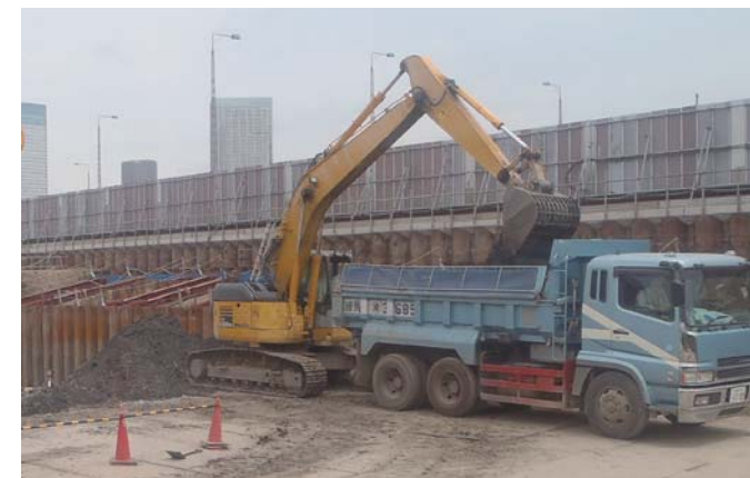
土壌積み込み状況
