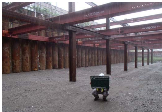
砕石層設置完了
