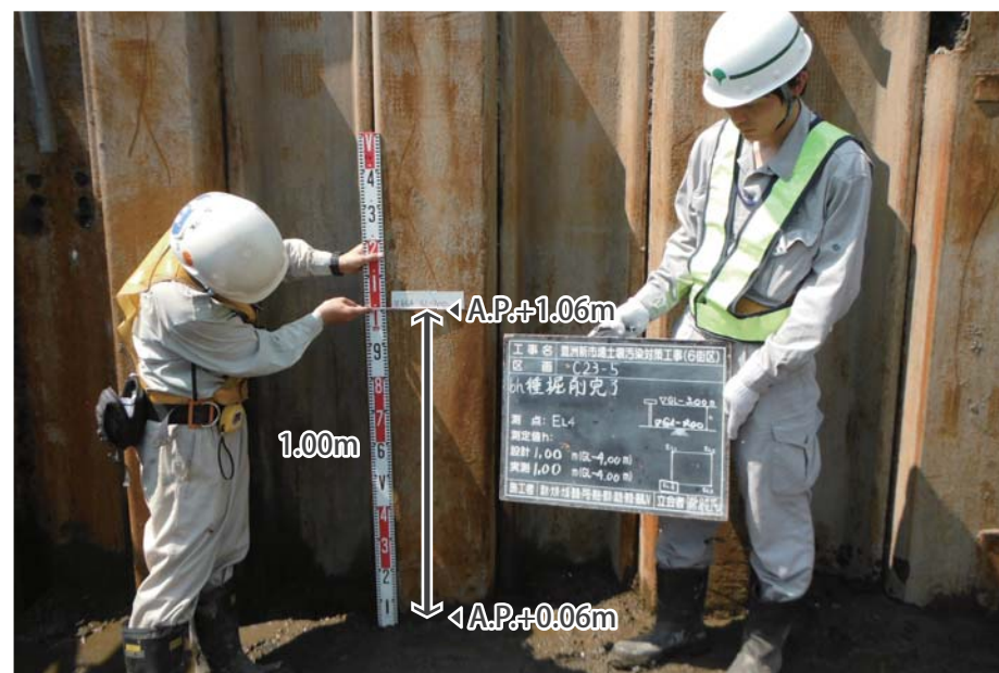
対策深さ確認
