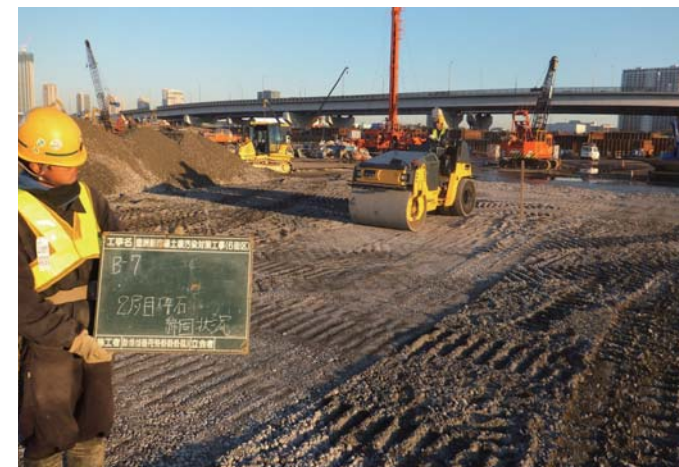
砕石 転圧状況
