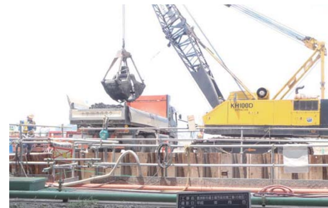
土壌積み込み状況
