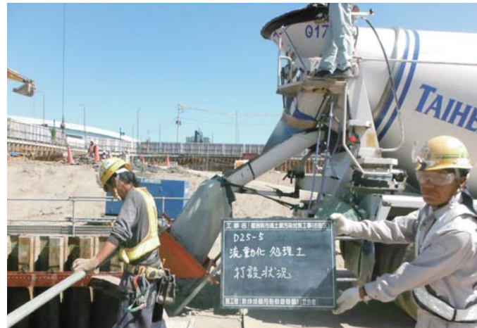
流動化処理土 打設状況
