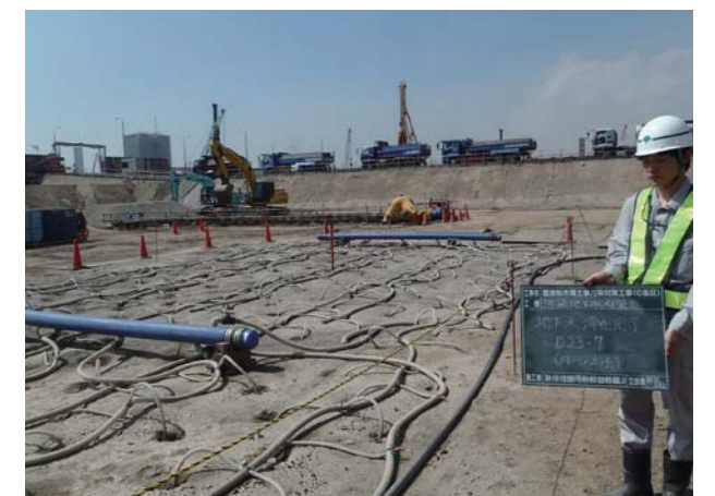
地下水対策完了確認
