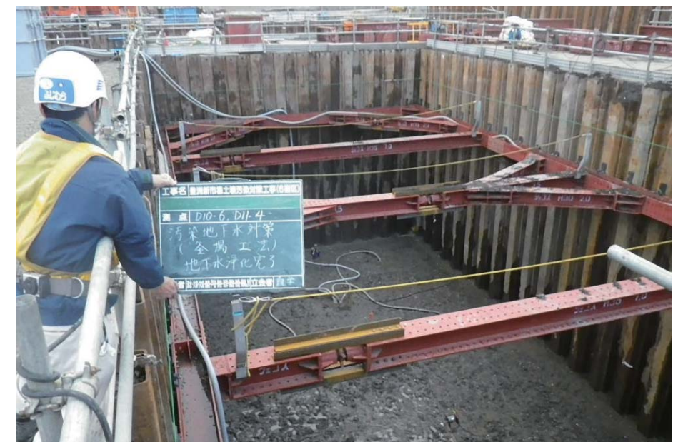
地下水対策完了確認
