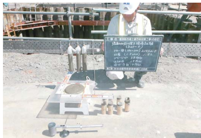
流動化処理土 品質確認
