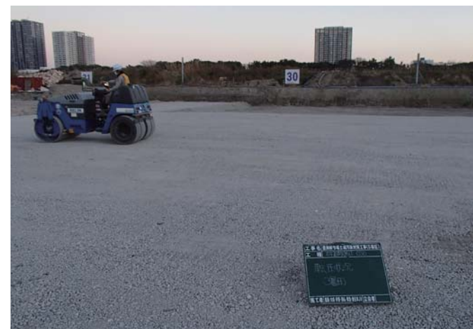
砕石転圧状況
