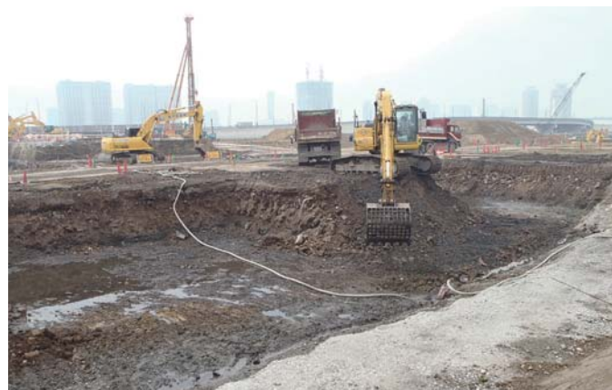
地中障害物 掘削状況
