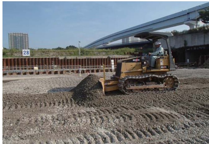
砕石敷均し状況
