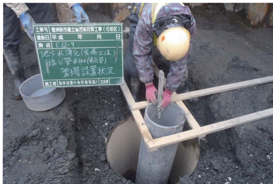
釜場設置状況
