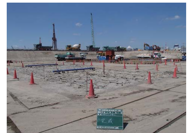
真空ドレーン設置状況
