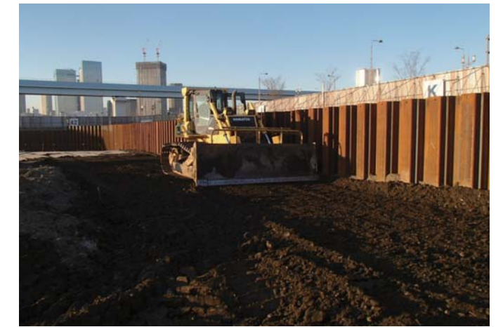
盛土 敷均し状況
