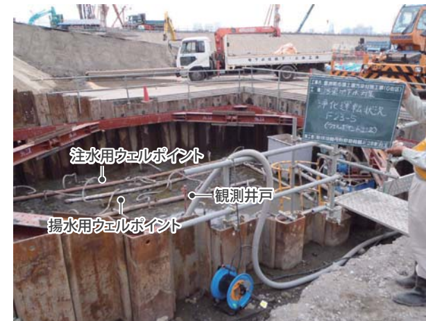
ウェルポイント運転状況
