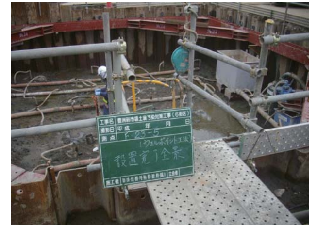
ウェルポイント設置状況
