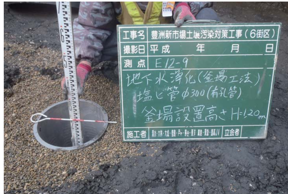
釜場設置状況
