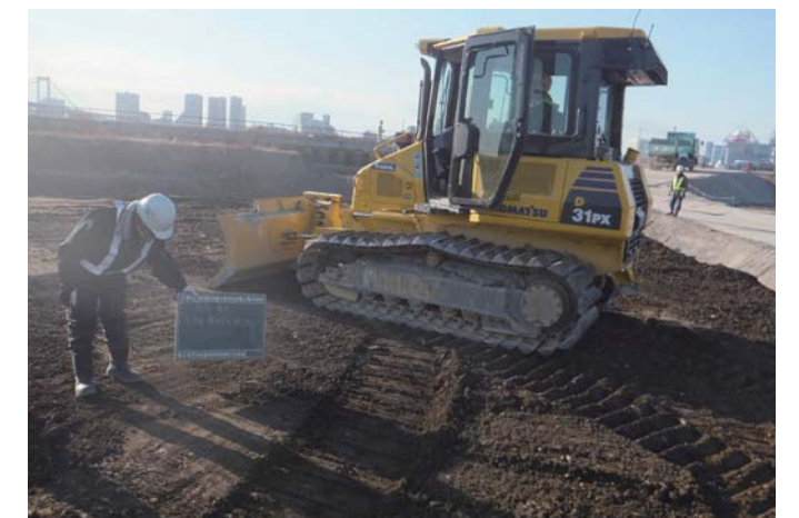
盛土 敷均し状況
