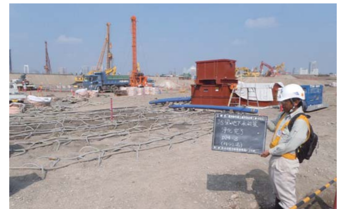
対策完了確認
