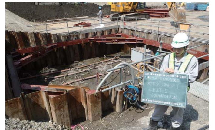
対策完了確認
