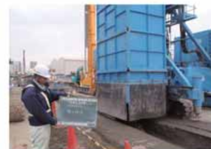
ソイルセメント壁造成状況 (6街区)
