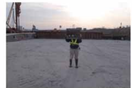
碎石層設置完了
