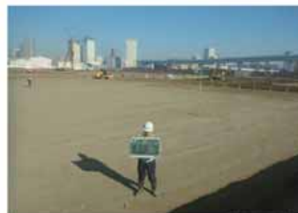
盛土完了(全景)
