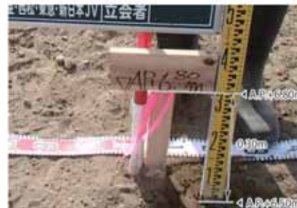
盛土高さの確認(拡大)
