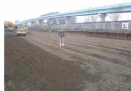
盛土転圧状況
