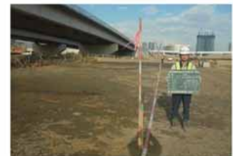
盛土完了(全景)
