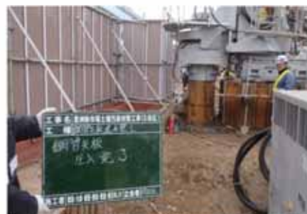
鋼管矢板打設状況 (圧入工法) (5街区)
