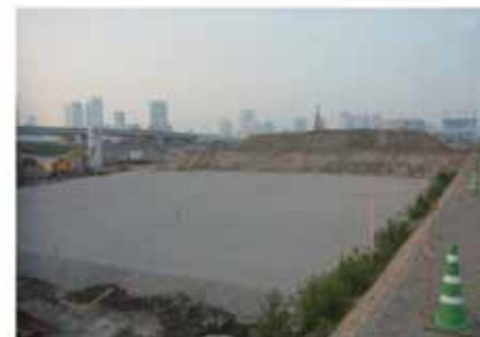
碎石層設置完了
