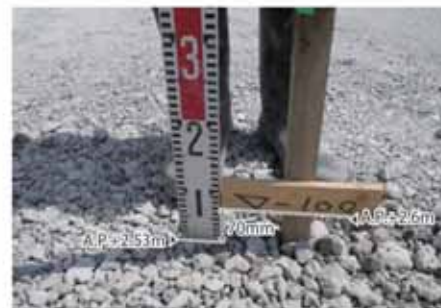
碎石層の高さ確認 (拡大)
