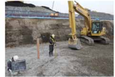
碎石敷き均し状況
