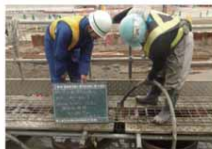
継手部充填材注入状況
