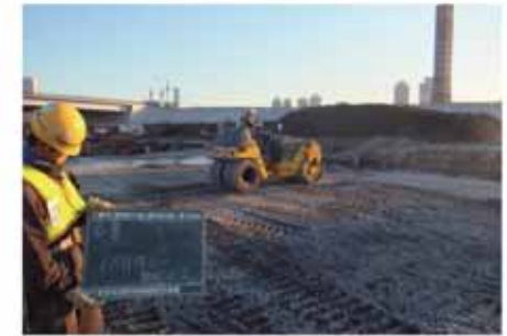
碎石転圧状況
