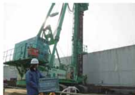
鋼管矢板打設状況 (中埋り工法) (7街区)
