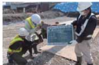
施工機械の確認
