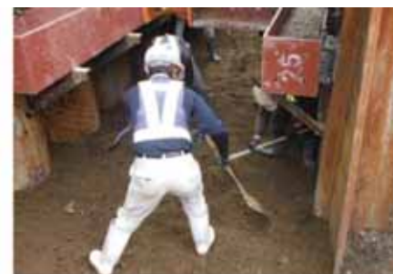
盛土敷均し状況
