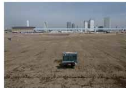
盛土完了(全景)
