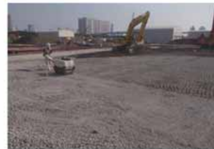
碎石転圧状況
