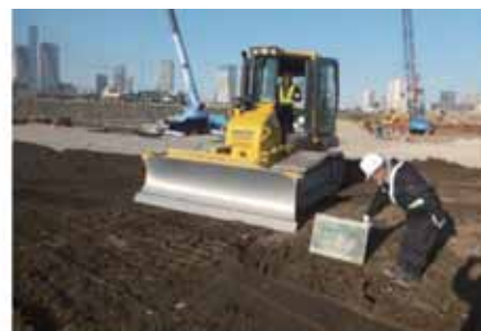
盛土敷均し状況
