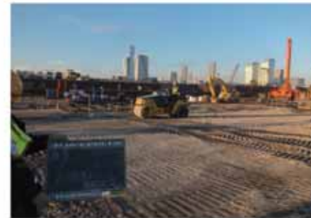
碎石転圧状況
