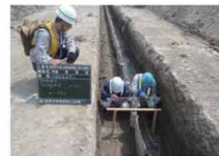
三層構造遮水壁設置完了
