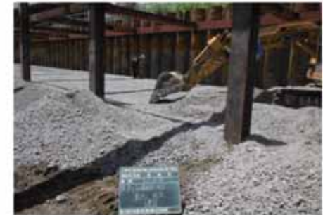
碎石敷き均し状況
