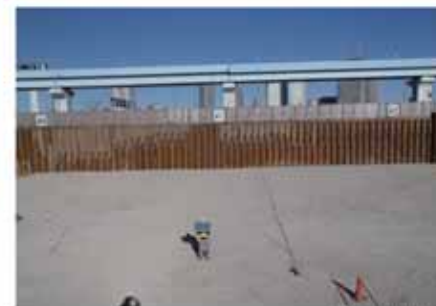
碎石層設置完了
