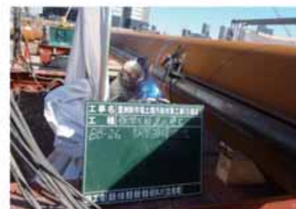
鋼管矢板継手状況 (溶接状況)
