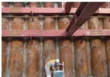
碎石層の高さ確認
