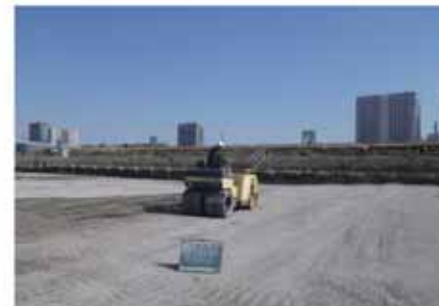
碎石転圧状況
