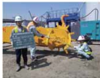
施工機械の確認
