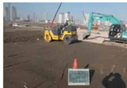
盛土転圧状況
