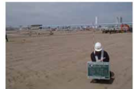
盛土完了(全景)
