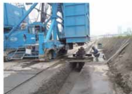
ソイルセメント壁造成状況 (5街区)
