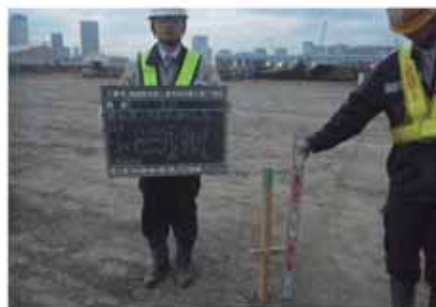
盛土高さの確認
