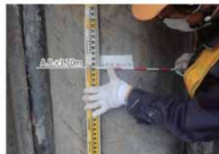
碎石層の高さ確認 (拡大)
