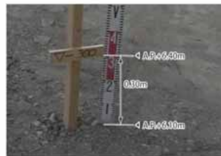
盛土高さの確認(拡大)
