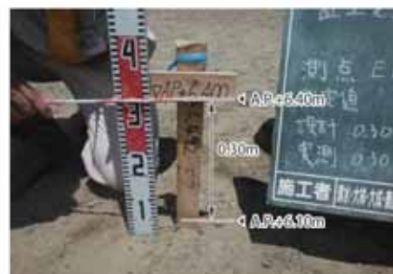
盛土高さの確認(拡大)
