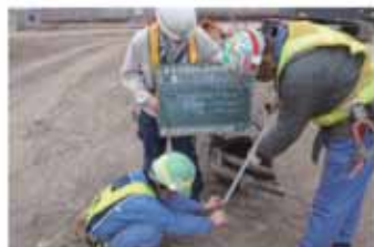
施工機械の確認
