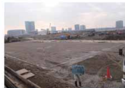
碎石層設置完了
