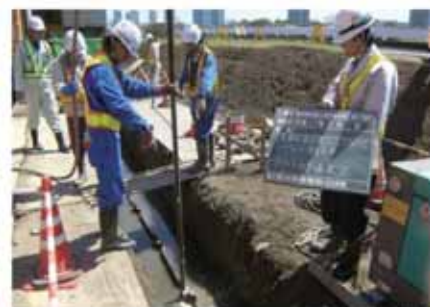
継手部充填材注入
