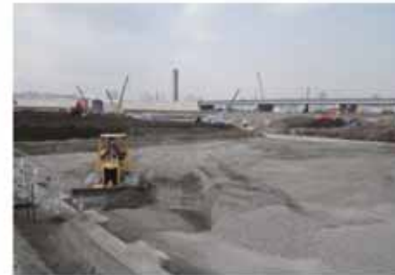
碎石敷き均し状況
