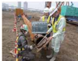
施工機械の確認
