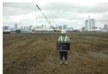
盛土完了(全景)
