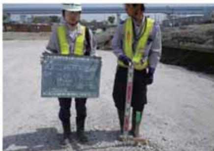
碎石層の高さ確認
