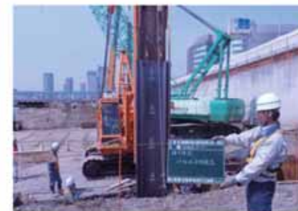
シートウォール建込み状況
