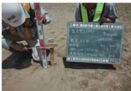
盛土高さの確認
