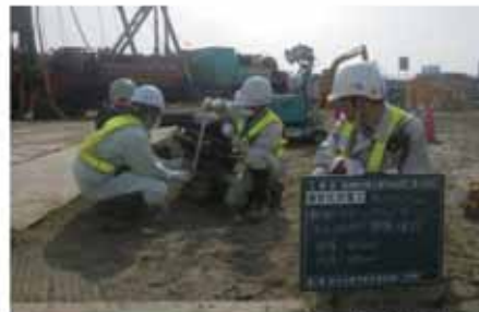
施工機械の確認
