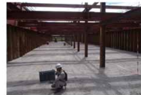
碎石層設置完了
