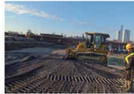
碎石敷き均し状況
