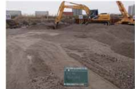
碎石敷き均し状況
