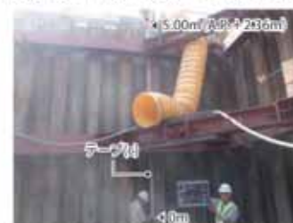
テープ(c)による基準高5.00mを確認
