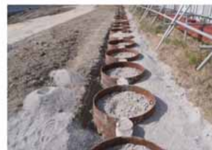
鋼管矢板遮水壁設置完了
