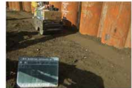
盛土転圧状況
