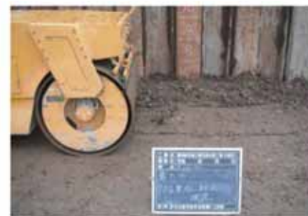
盛土転圧状況
