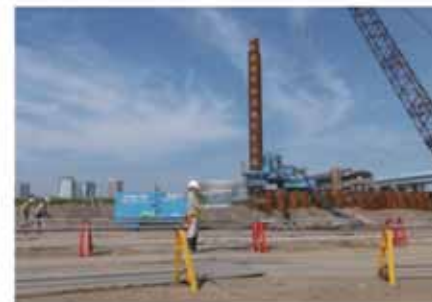
鋼管矢板打設状況 (圧入工法) (6街区)
