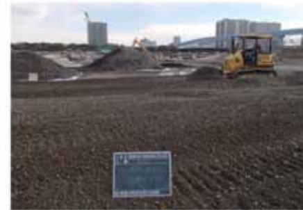
碎石敷き均し状況
