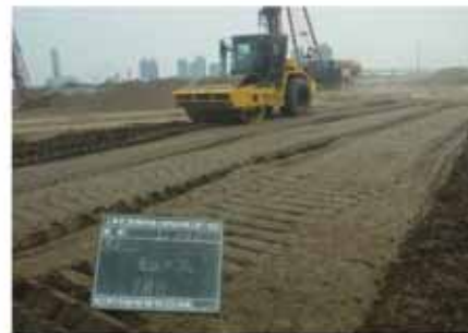
盛土転圧状況
