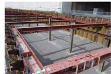
碎石層設置完了
