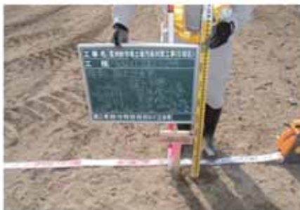
盛土高さの確認
