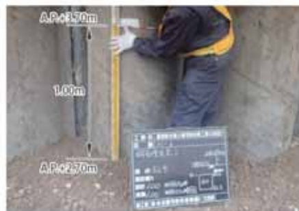
碎石層の高さ確認
