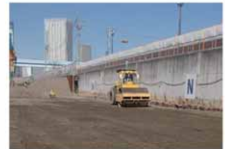
盛土転圧状況
