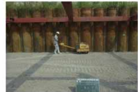
碎石転圧状況
