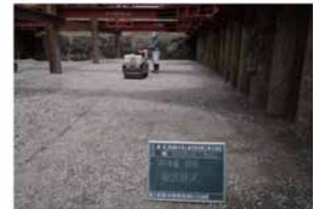
碎石転圧状況
