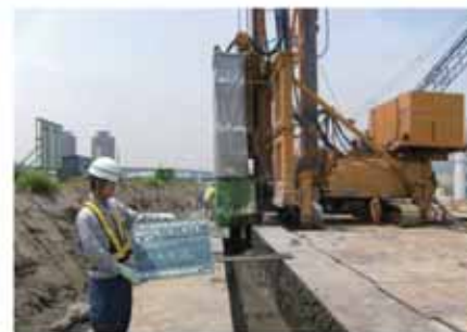
ソイルセメント壁造成状況 (7街区)
