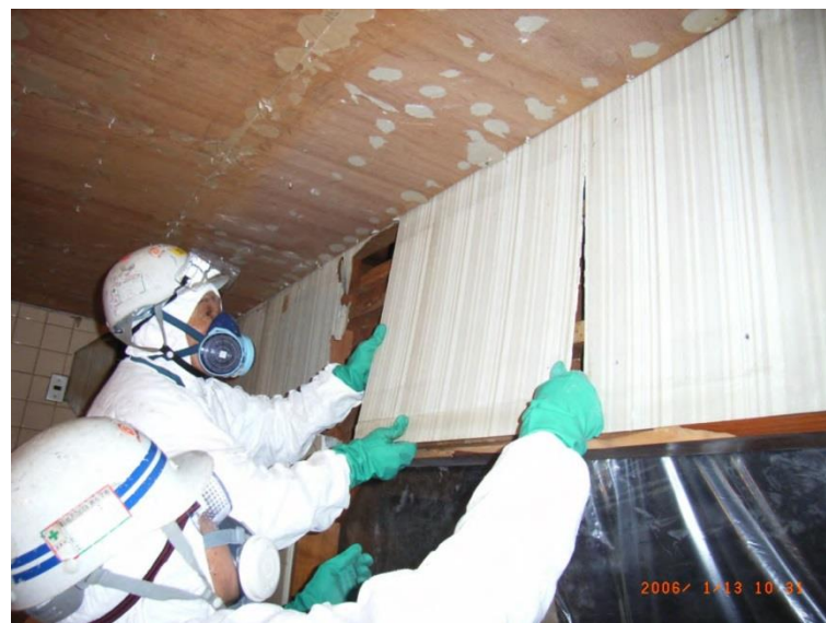
成型板の取り外し (手ばらし)
