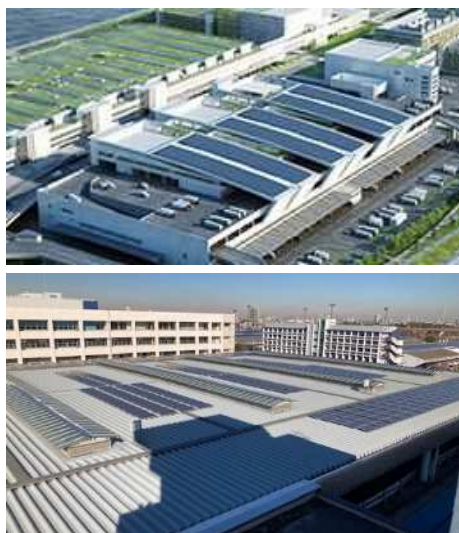
環境問題への取組 (太陽光パネルの設置)
