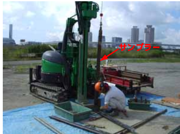
サンプラーの引き上げの状況
