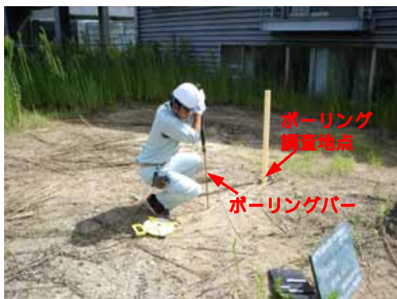
ボーリングバーによるガス採取孔の設置状況
