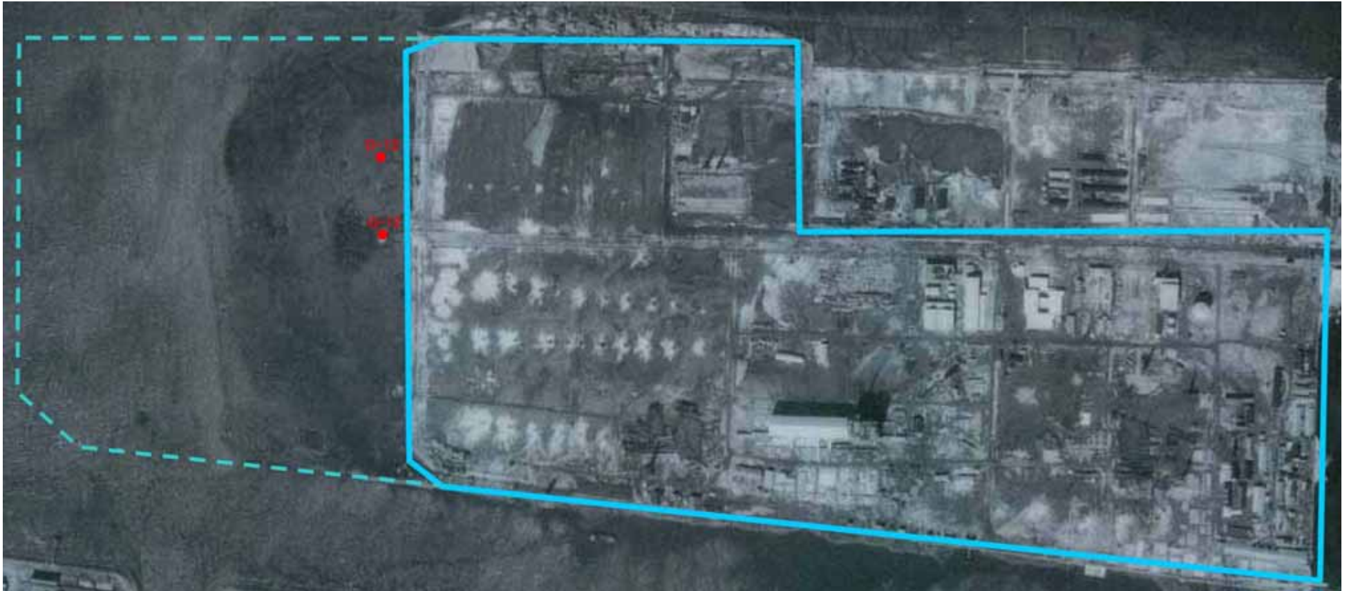
図 4.14.1 東京ガス（株）豊洲工場操業時の航空写真（昭和 31 年）
