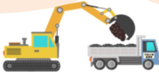
汚染土を掘削した箇所は、基準に適合した材料で埋め戻す
