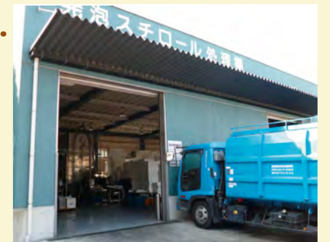
発泡スチロール処理場
