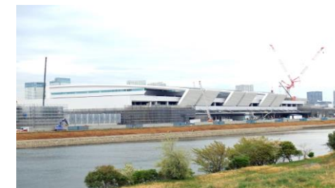
水産卸売場棟外観
