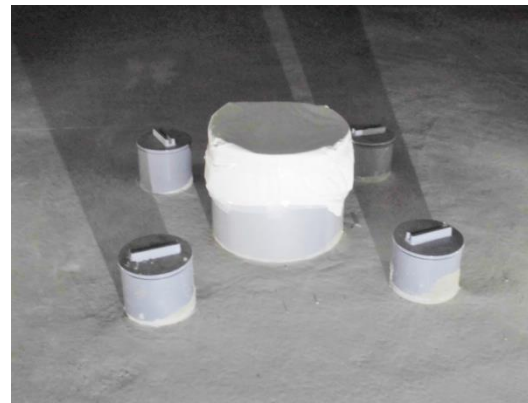
(地下ピット内での揚水ポンプの設置状況)
