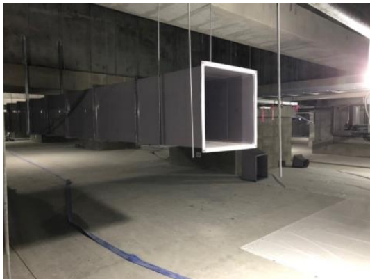
(換気工事の実施状況)
