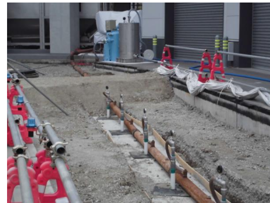
(真空ポンプによる揚水の実施状況)
