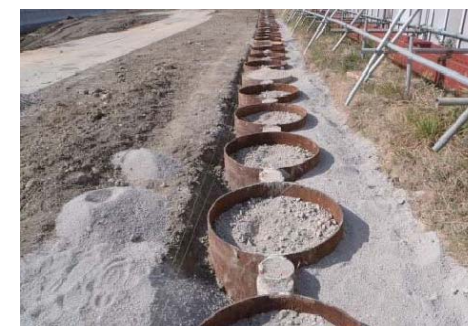
鋼管矢板遮水壁設置完了
