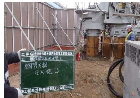
鋼管矢板打設状況 (圧入工法) (5街区)
