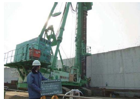
鋼管矢板打設状況 (中掘り工法) (7街区)
