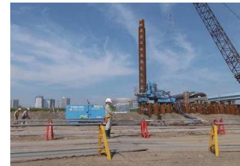
鋼管矢板打設状況 (圧入工法) (6街区)
