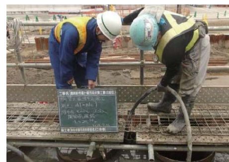
継手部充填材注入状況
