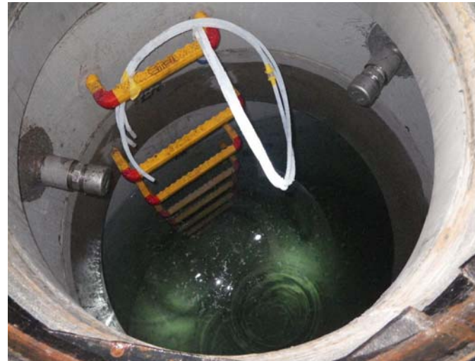
観測用人孔内現況写真 (315下⑥観測孔)
