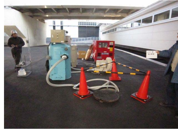
換気状況写真 (観測用人孔②)
