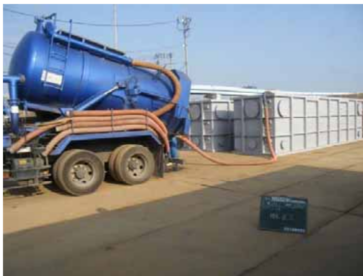
写真-4 バキューム車にて水処理施設に運搬
