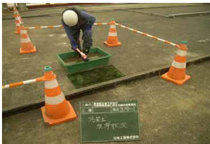
写真-11 長靴付着汚染土の除去作業
