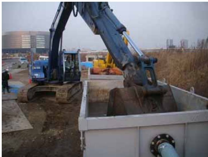
写真-3 水タンクにてバケツ泥落とし作業
