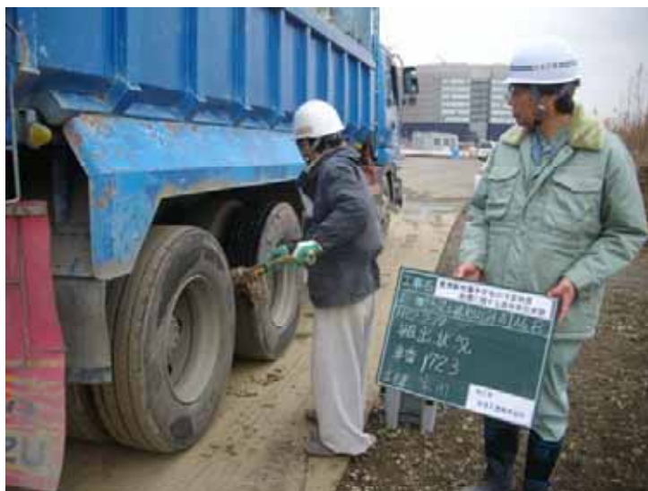
写真-10 搬出車両の汚染土除去作業
