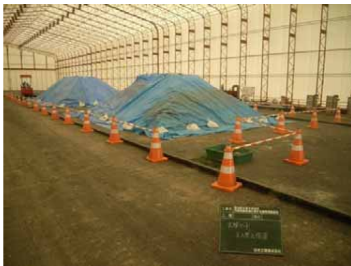
写真-9 実験ヤードバリエース設置状況
