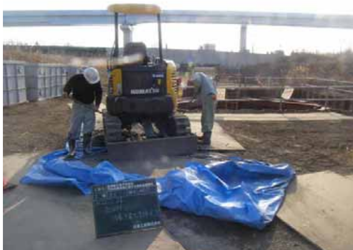
写真-2 車両泥落とし作業
