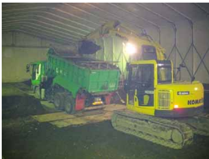
写真-6 密閉型車両への積み込み作業
