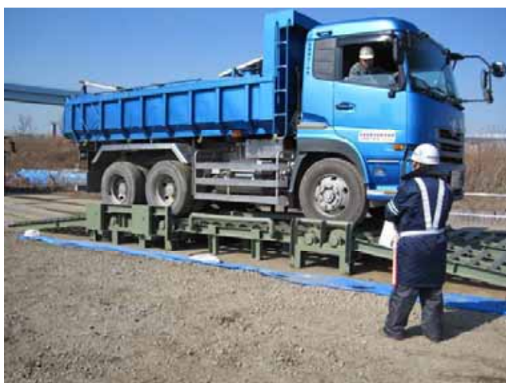
写真-12 スパッツによるタイヤ泥落とし作業
