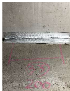
排水溝・壁取合部
