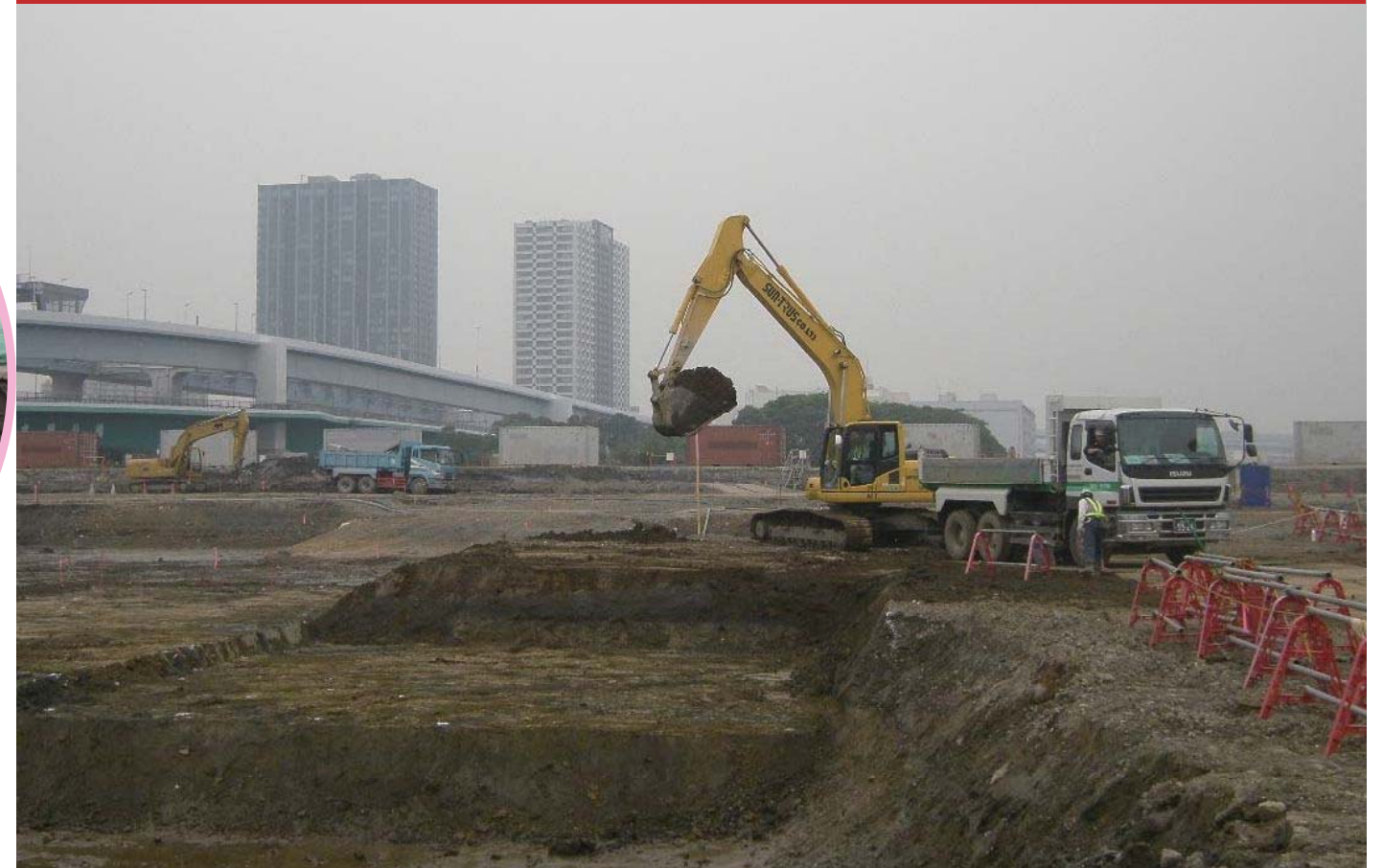
C 土壌の掘削① (工場操業時地盤面～ A.P.+2m)
