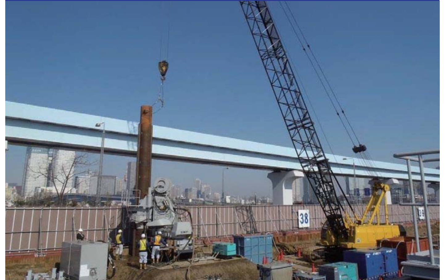
B 遮水壁の設置 (鋼管矢板遮水壁)
