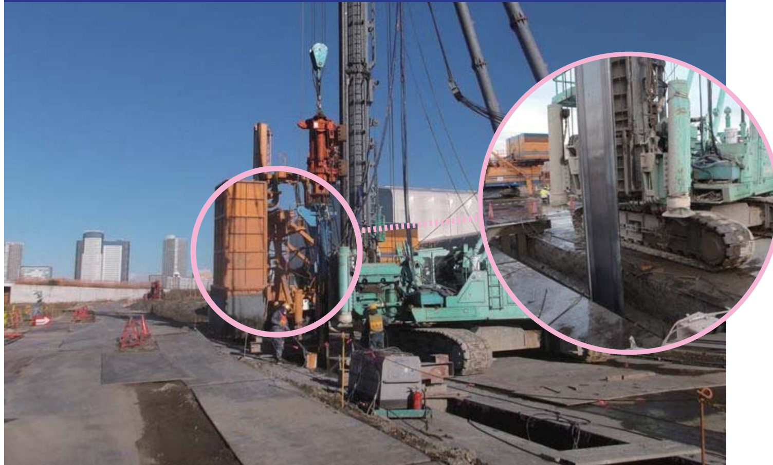
B 遮水壁の設置 (三層構造遮水壁)
