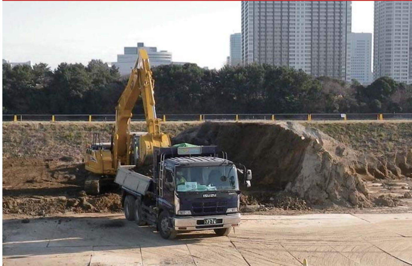
A 盛土の掘削
